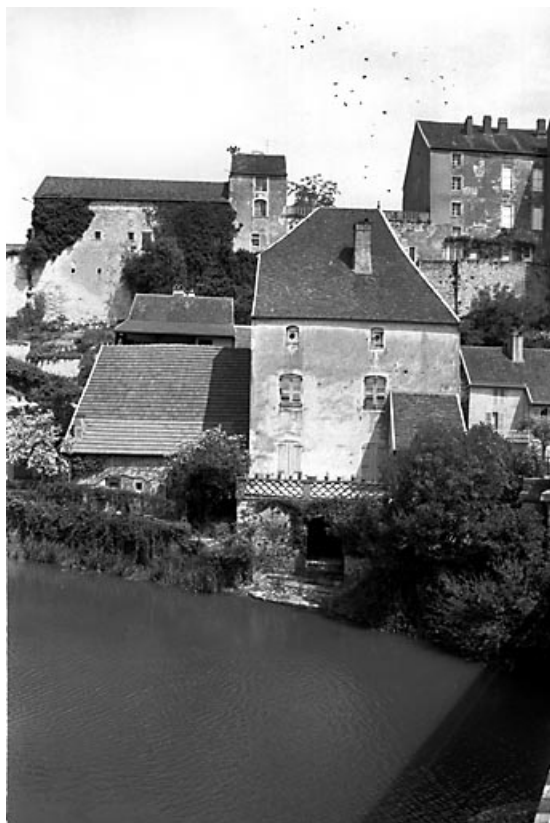
Vue d'ensemble depuis l'Ognon.
