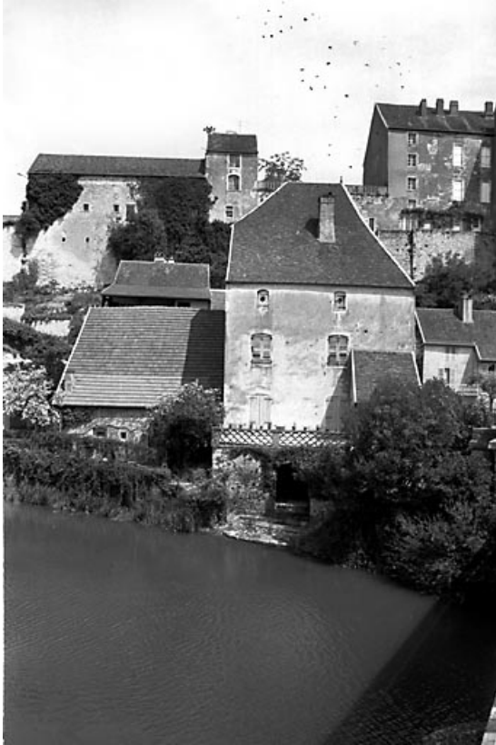
Vue d'ensemble depuis l'Ognon.
