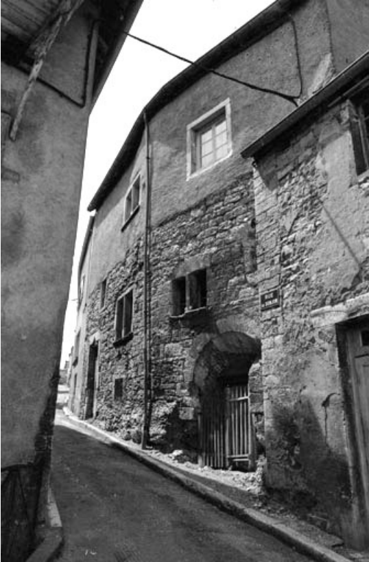
Façade antérieure vue de trois quarts droit. 70, Pesmes
