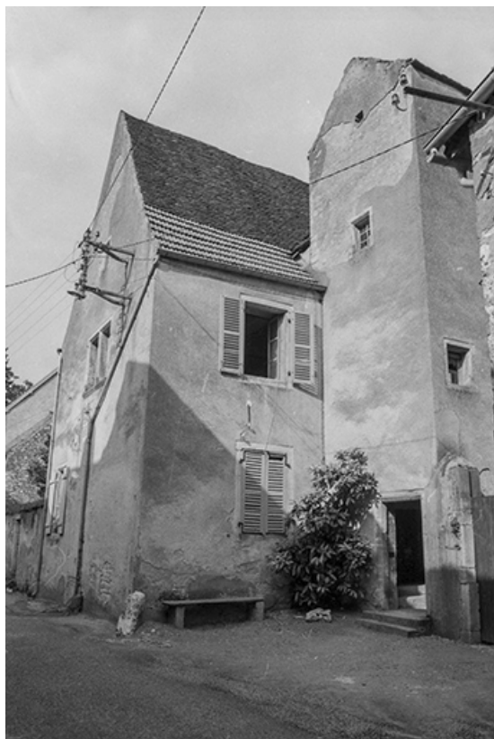
Vue de trois quarts droit depuis la rue. 70, Pesmes
