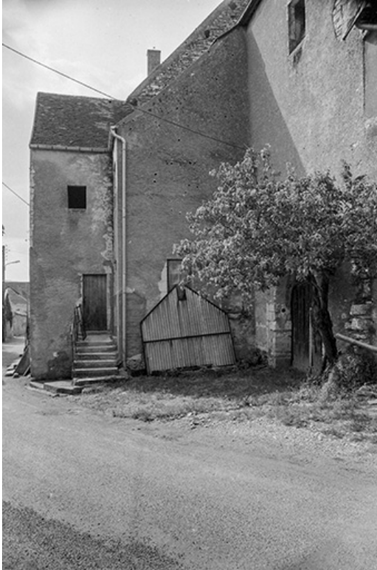
Façade rue des Châteaux, trois quarts gauche. 70, Pesmes rue des Châteaux
