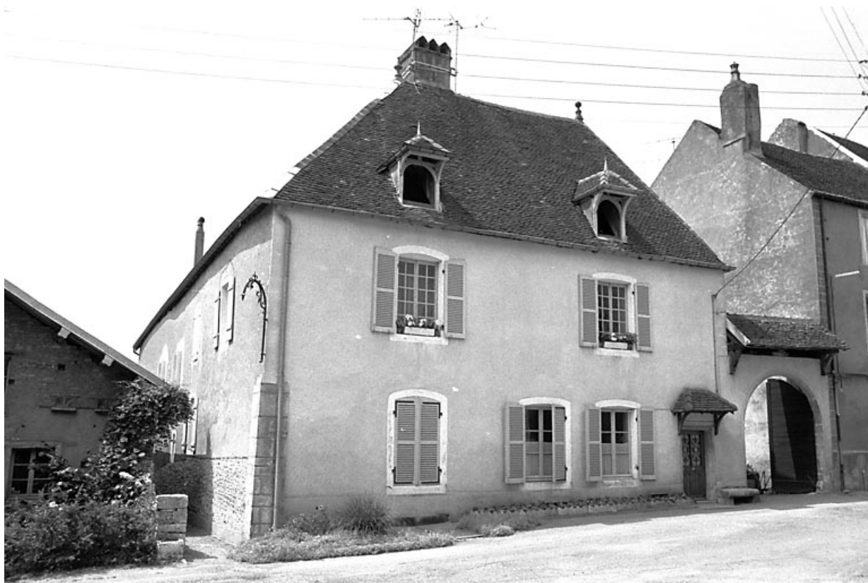
Vue d'ensemble de l'habitation depuis la rue. 70, Pesmes
