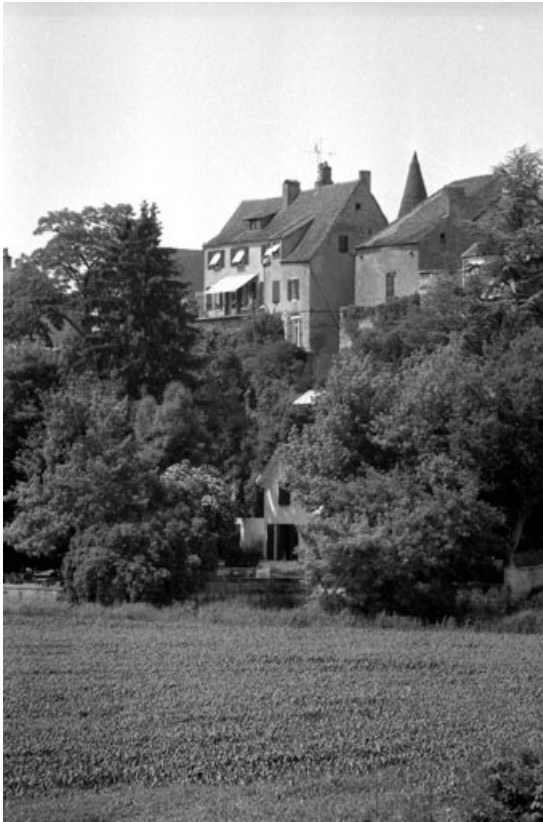
Façade postérieure, vue éloignée.
