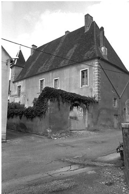
Vue d'ensemble de l'ancienne maison du Prieur.
