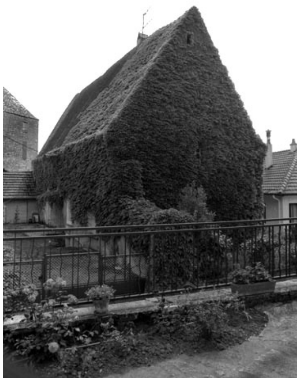
Vue d'ensemble de l'ancienne chapelle.
