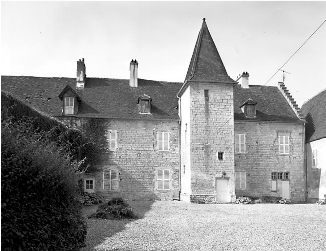
Façade sur cour.
