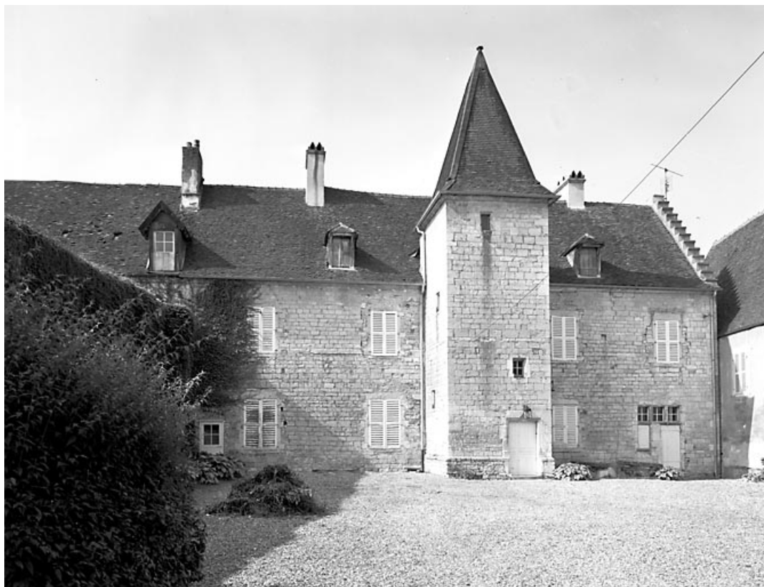
Façade sur cour.
