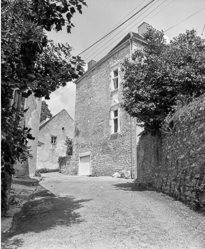
Façade latérale droite.
