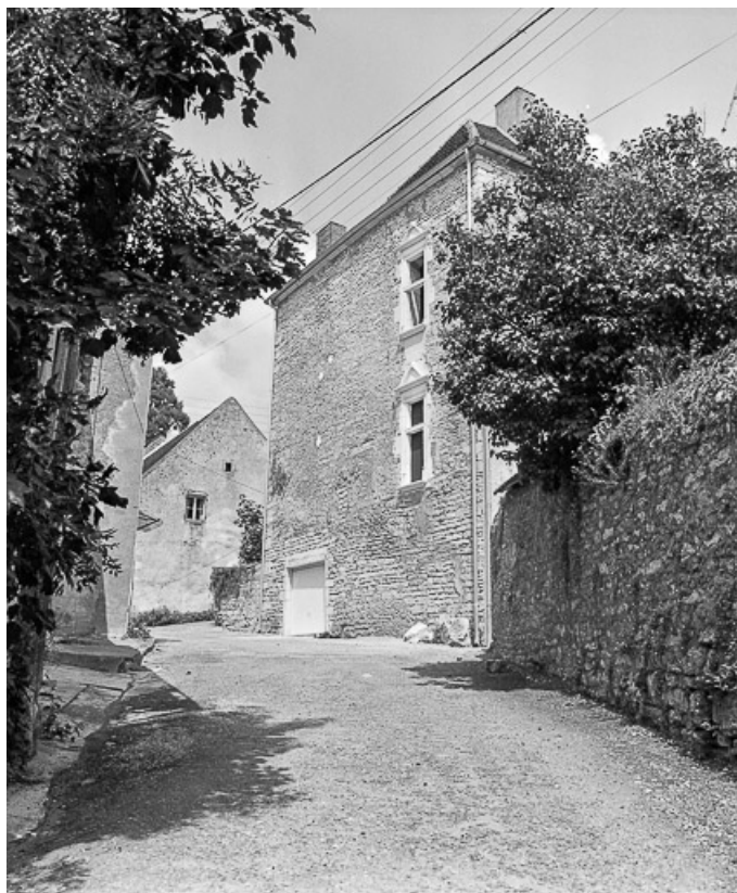
Façade latérale droite.
