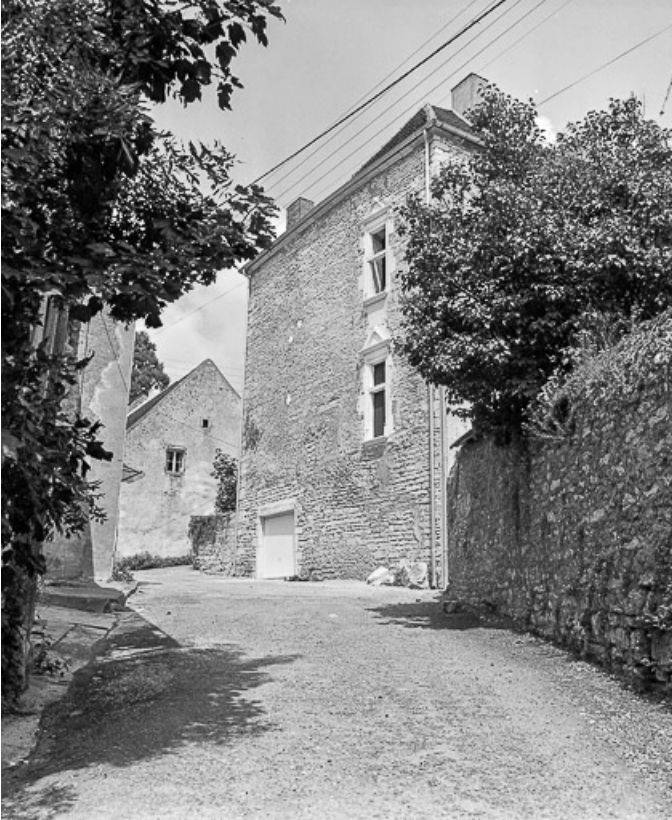
Façade latérale droite.
