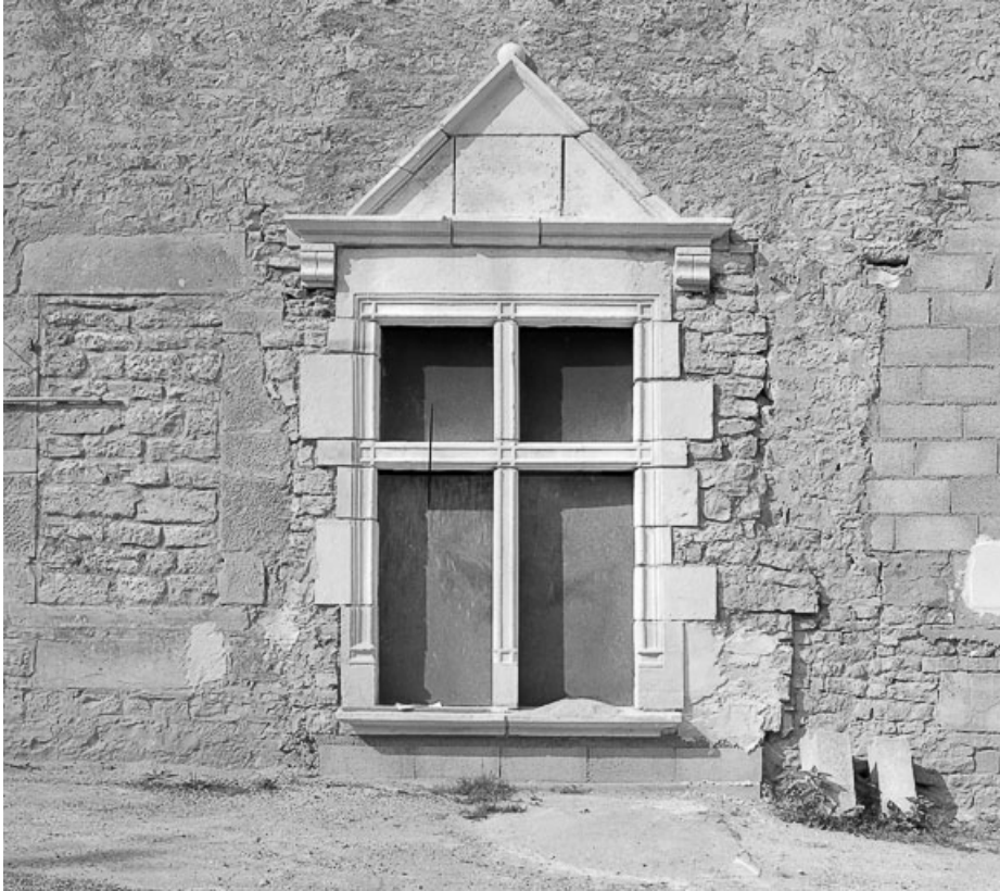
Détail d'une fenêtre restaurée de l'habitation.
