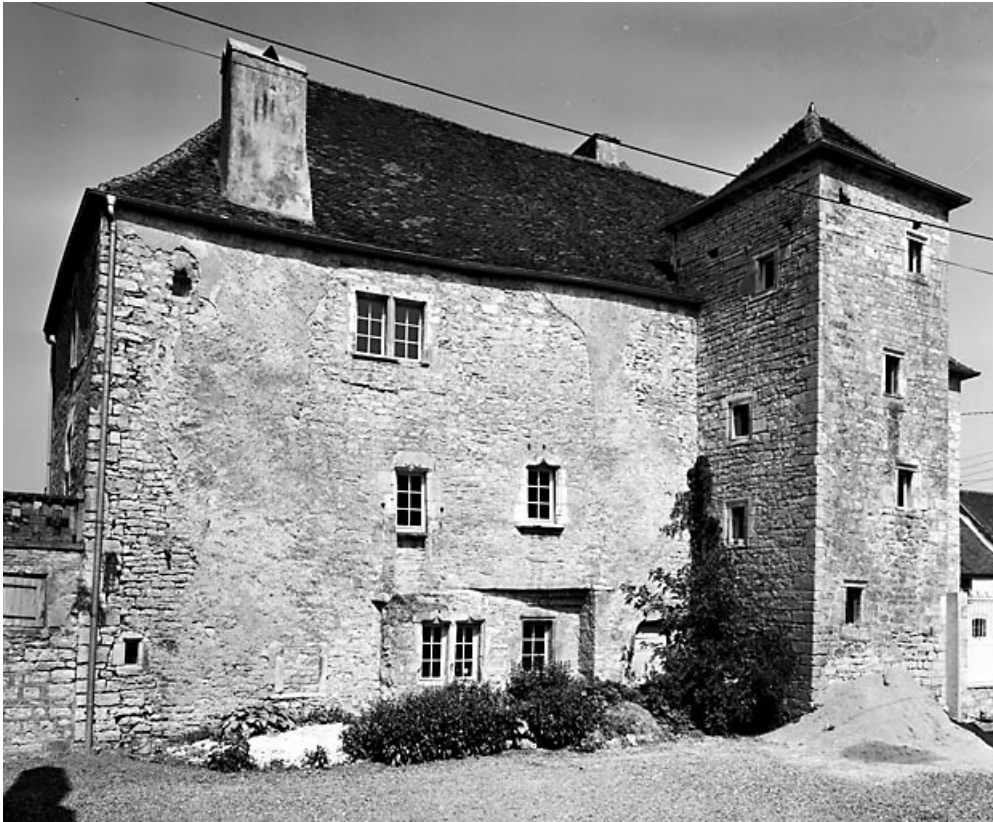
Façade latérale gauche.
