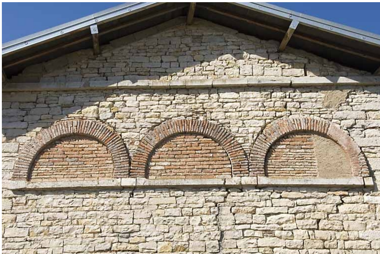
Logement (?) nord. Détail d'arcatures sur le pignon.
