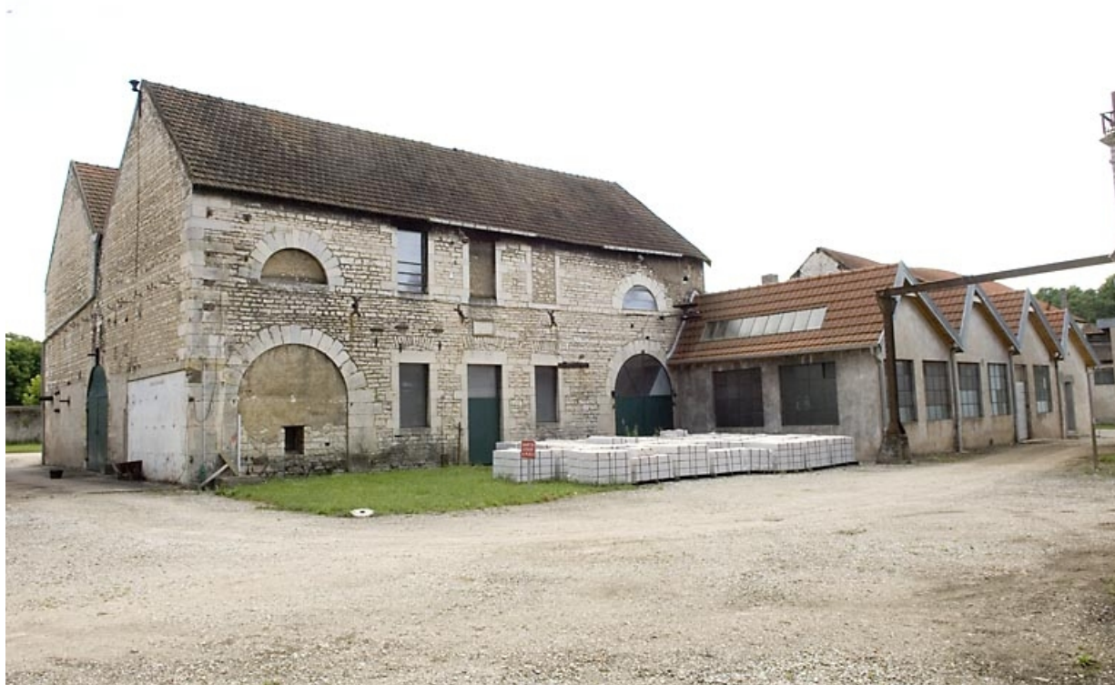
Bâtiment du haut fourneau est, et extension vus de trois quarts.
