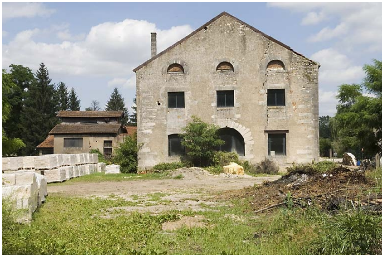
Pignon du bâtiment du haut fourneau ouest.
