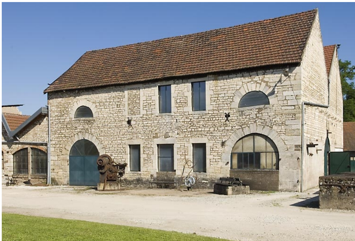
Bâtiment du haut fourneau est.
