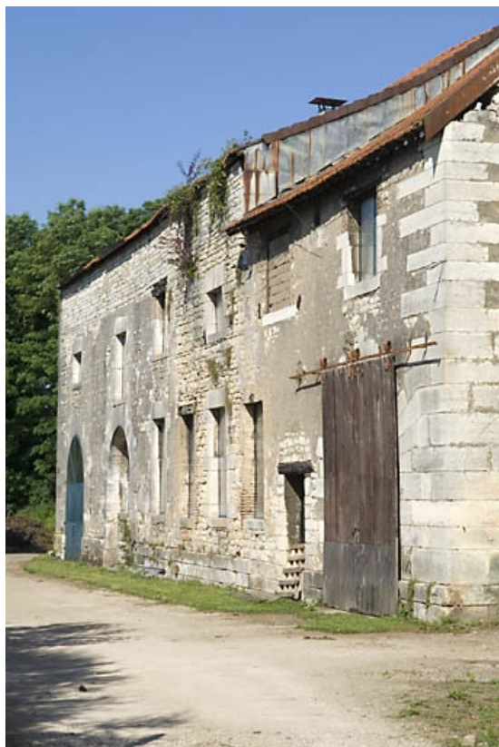
Bâtiment du haut fourneau ouest.
