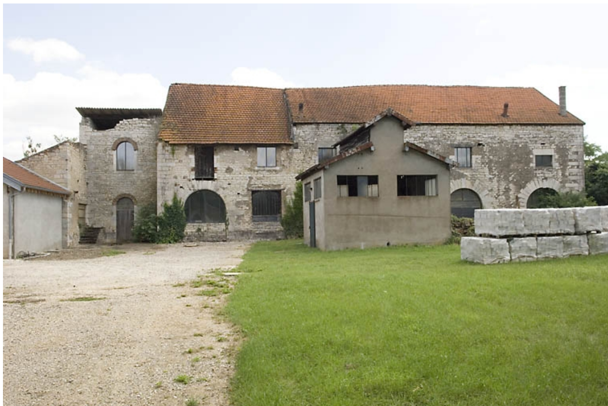
Façade nord du haut fourneau ouest.
