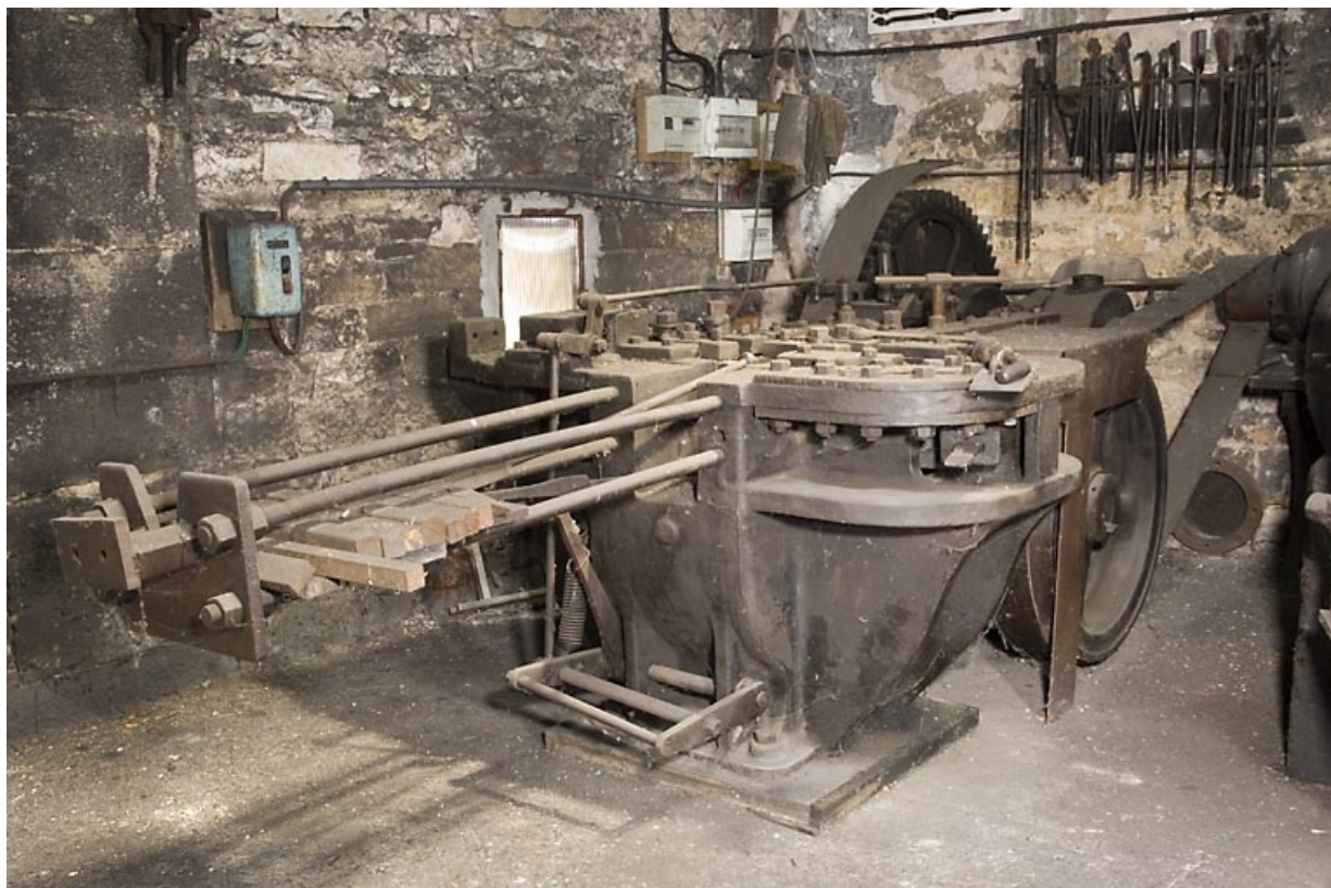
Atelier est. Machine à refouler dite "locomotive" (provient des Forges de Fraisans). 70, Pesmes, lieudit : les Forges
