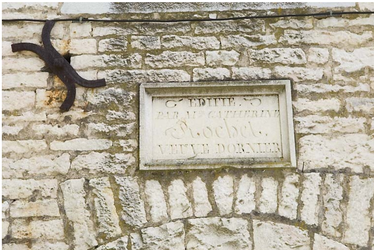
Bâtiment du haut fourneau. Cartouche sur la façade nord.
