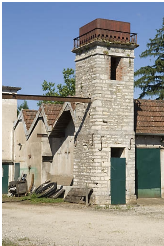
Magasin et réservoir industriel (?) vus de trois quarts.
