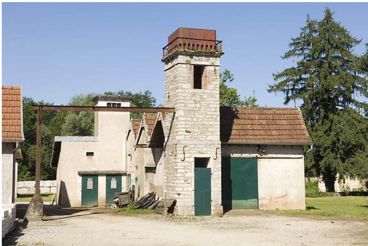
Transformateur, magasin et réservoir industriel (?).
