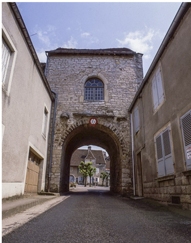
Porte Saint-Hilaire : façade extérieure.
