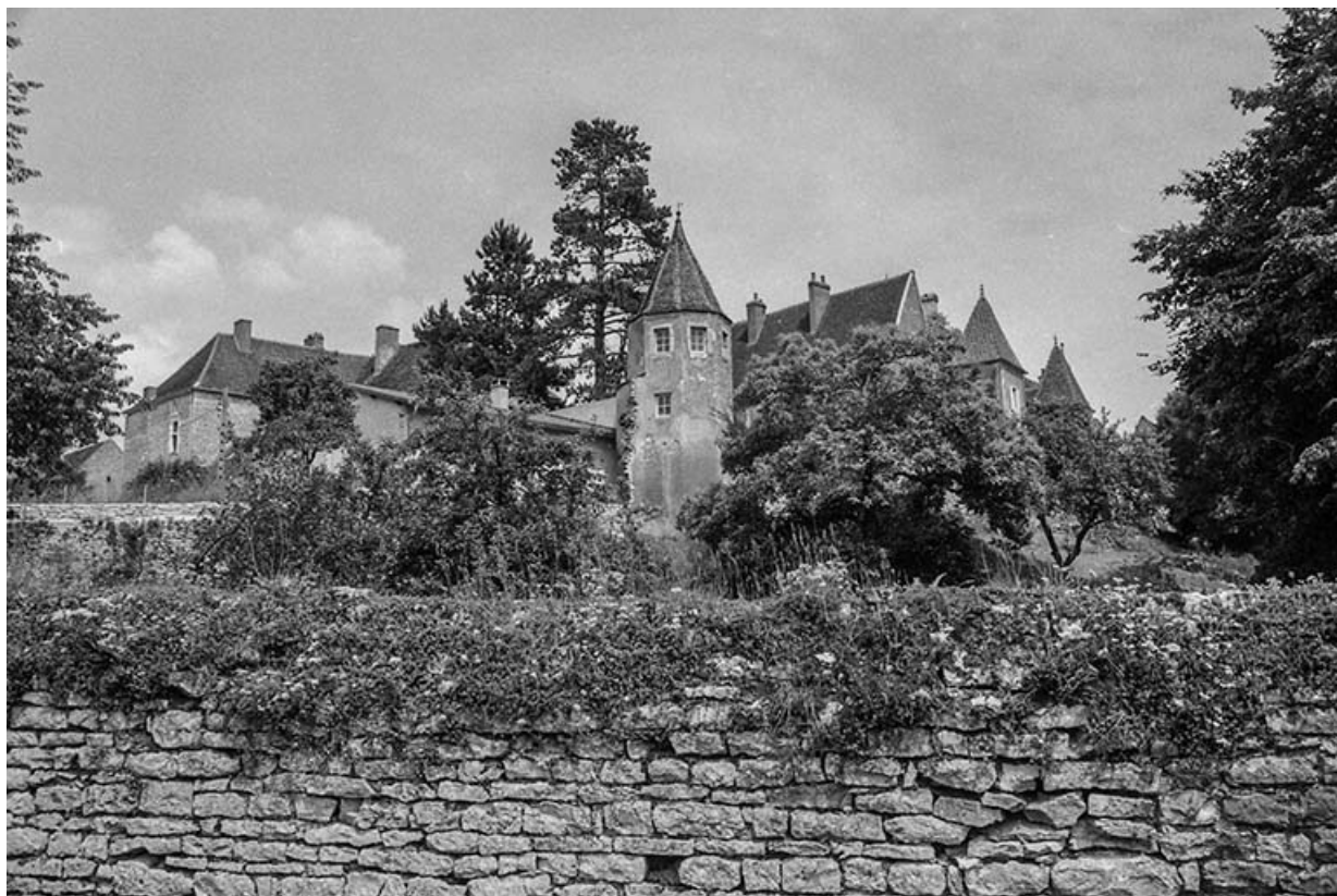
Rempart et tourelle située sur le tracé sud des fortifications (transformée en habitation). En arrière-plan, les demeures situées rue des Châteaux.
