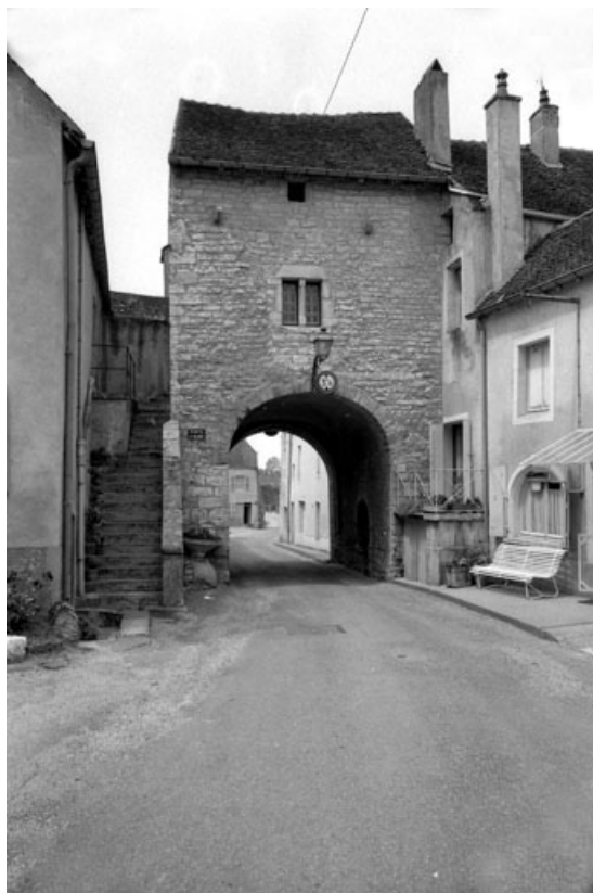
Porte Saint-Hilaire : façade intérieure. 70, Pesmes
