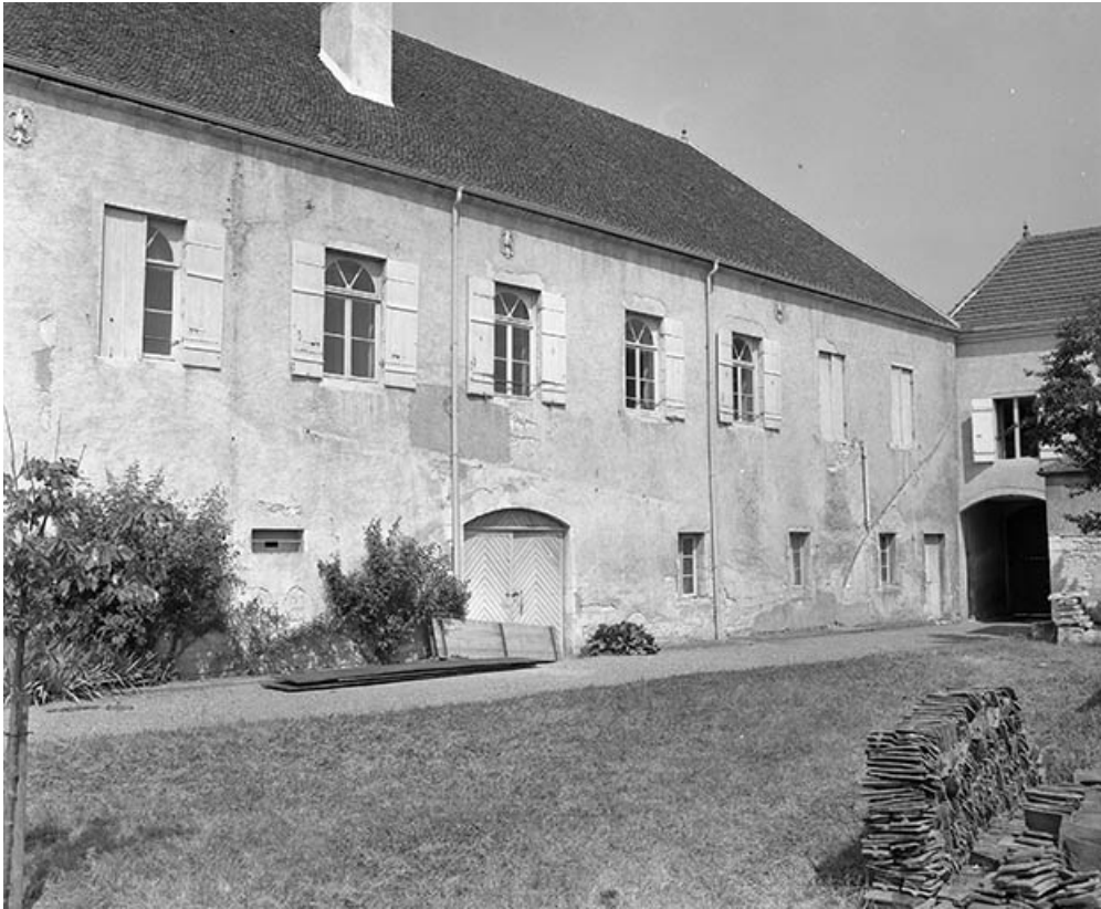
Les communs : façades antérieures.
