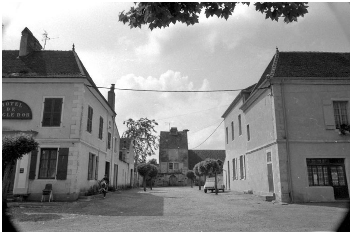
Bâtiments droit et gauche à l'entrée de l'ancienne cour d'honneur.
