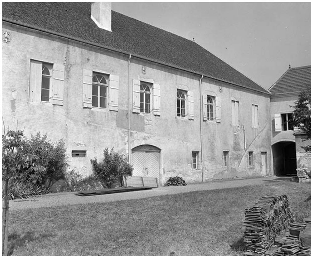
Les communs : façades antérieures.
