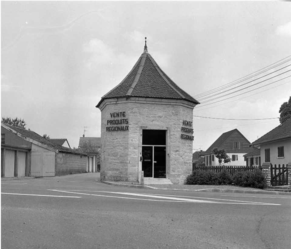
Tourelle gauche à l'entrée de l'ancien jardin du château.
