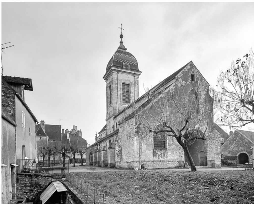
Extérieur : façade ouest.
