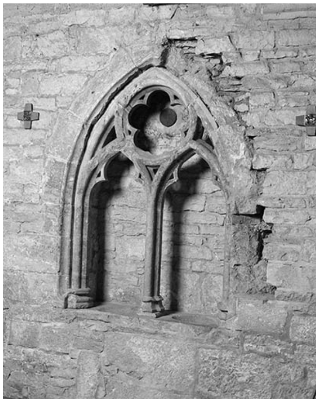
Intérieur : détail de la chapelle à droite du chœur, lavabo. 70, Pesmes place du Portail
