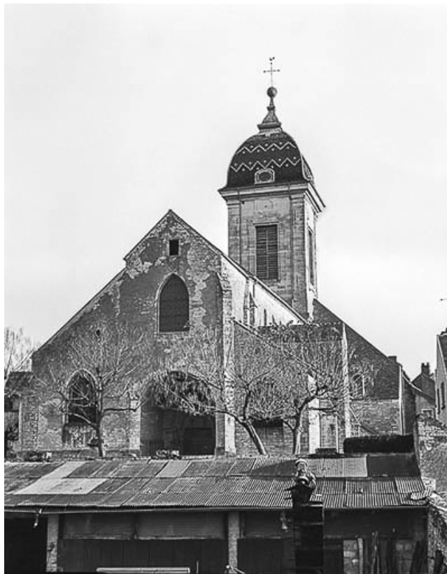
Extérieur : vue d'ensemble depuis le cimetière.
