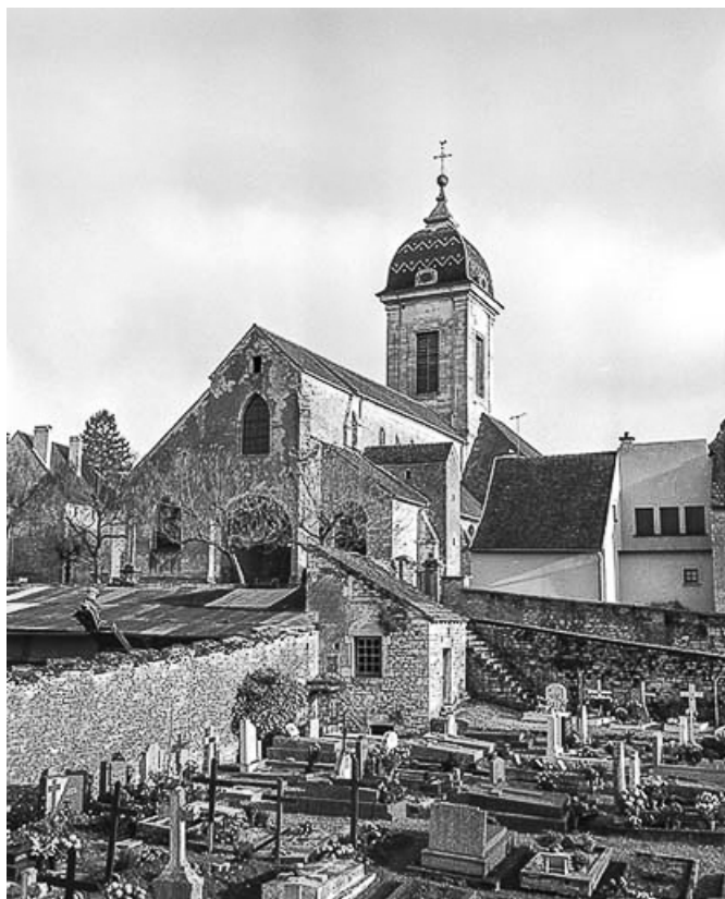
Extérieur : vue d'ensemble depuis le cimetière.
