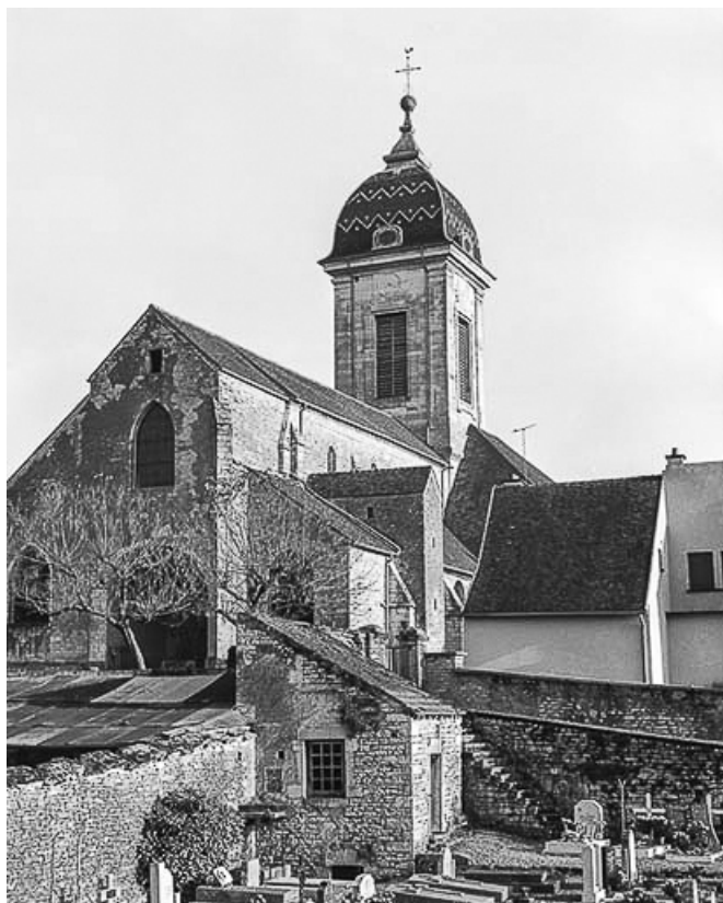
Extérieur : vue d'ensemble depuis le cimetière.
