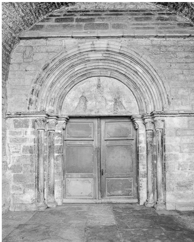
Exérieur : portail ouest.
