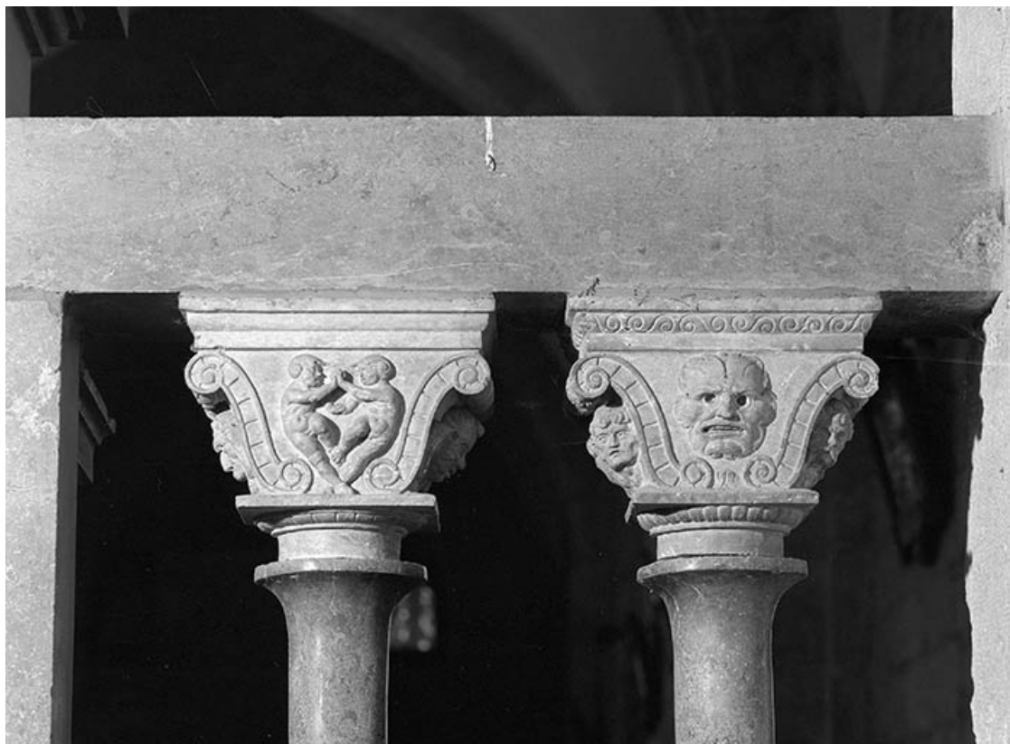
Intérieur : détail des chapiteaux de la partie gauche de la clôture de la chapelle du baptistère. 70, Pesmes place du Portail
