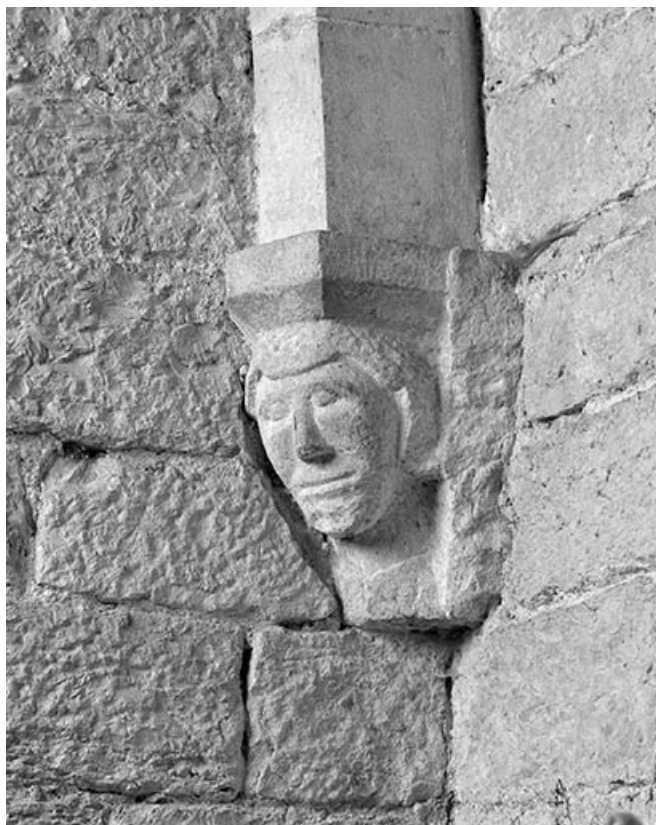
Intérieur : détail du chapiteau à droite du chœur.
