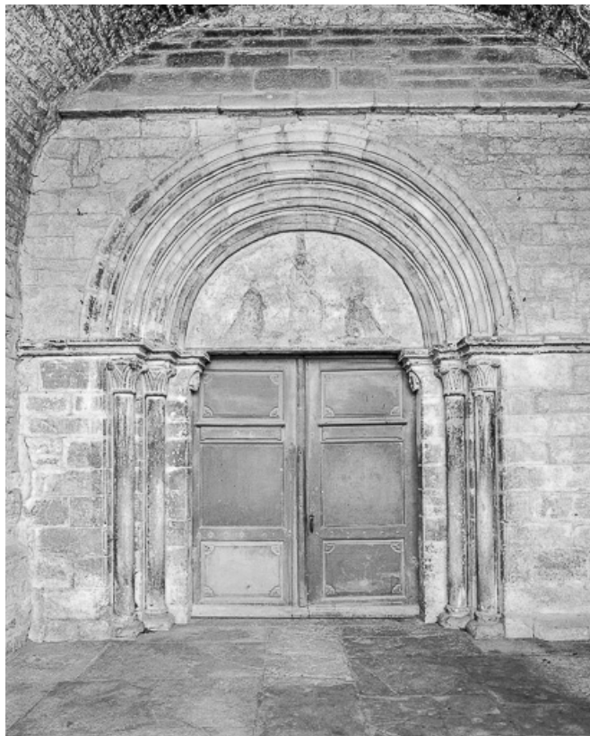
Exétérieur : portail ouest.
