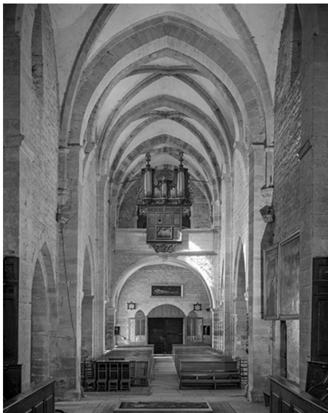
Intérieur : nef depuis le chœur.
