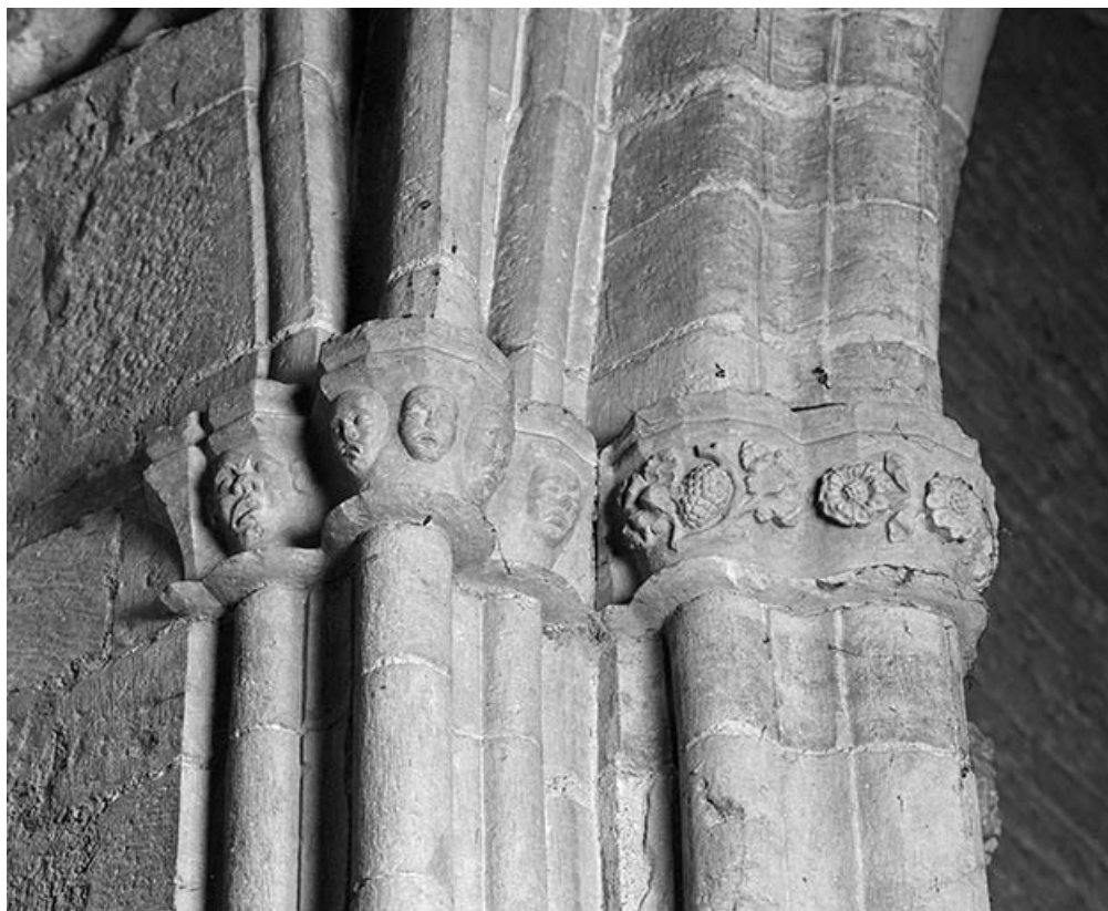
Intérieur : détail des chapiteaux gauches entre la 1ère et la 2e travée située à droite du choeur. 70, Pesmes place du Portail
