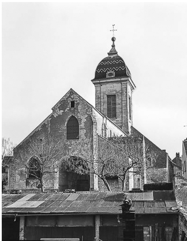
Extérieur : vue d'ensemble depuis le cimetière.
