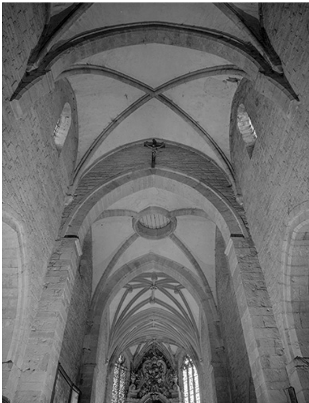
Intérieur : voûtes de la nef et du chœur.
