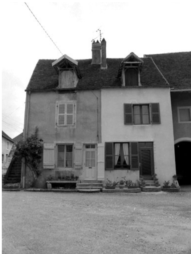
Maisons situées place Saint-Hilaire : façades antérieures. 70, Pesmes
