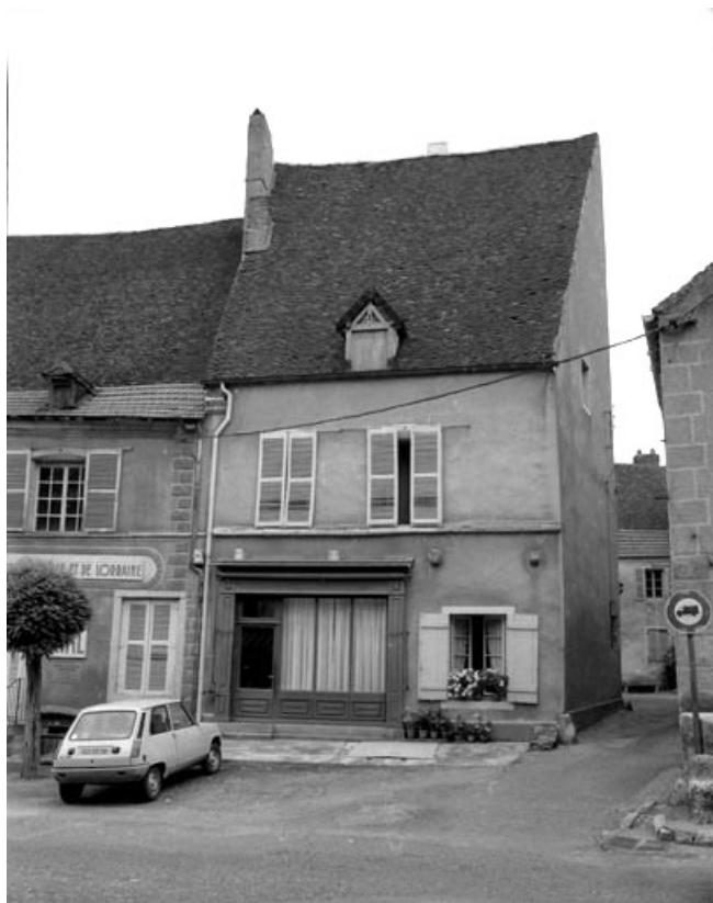
Maison située 33 Grande Rue : façade antérieure. 70, Pesmes
