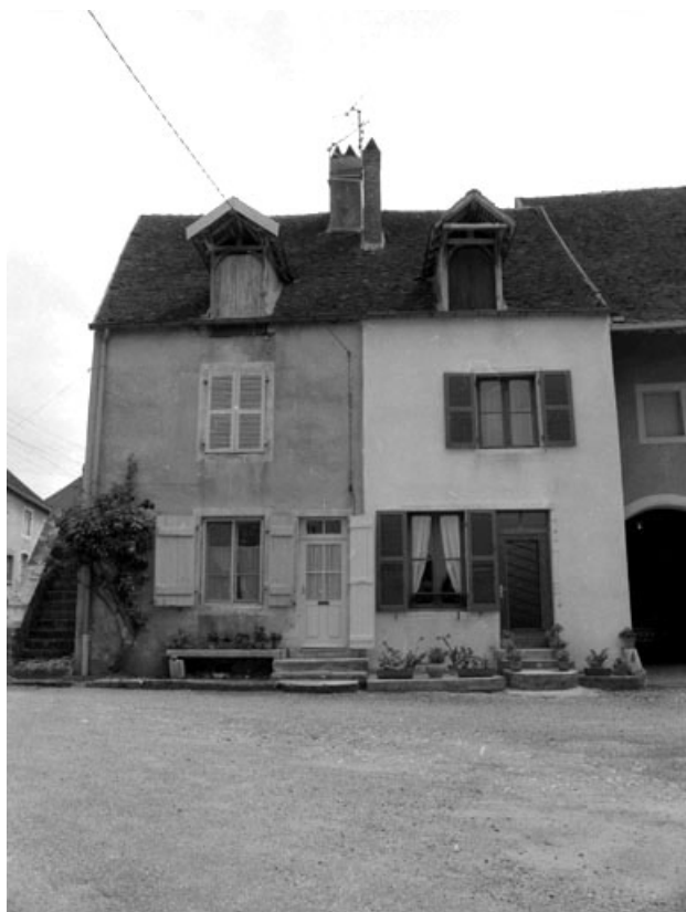
Maisons situées place Saint-Hilaire : façades antérieures. 70, Pesmes
