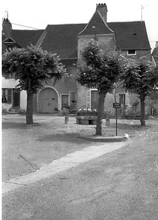
Vue de la façade antérieure depuis la place.
