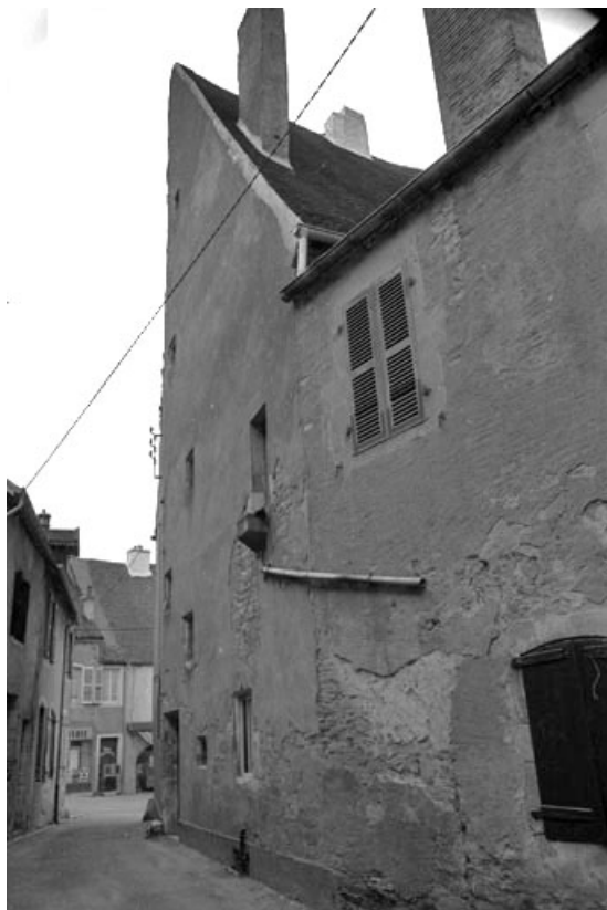
Maison située 33 Grande Rue avec escalier en vis intégré dans le volume de l'édifice. 70, Pesmes
