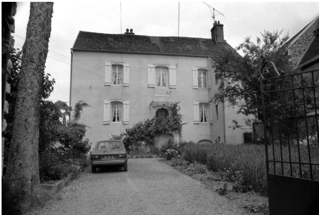
Presbytère, actuellement maison, situé 7 rue Gollu : façade antérieure sur cour. 70, Pesmes
