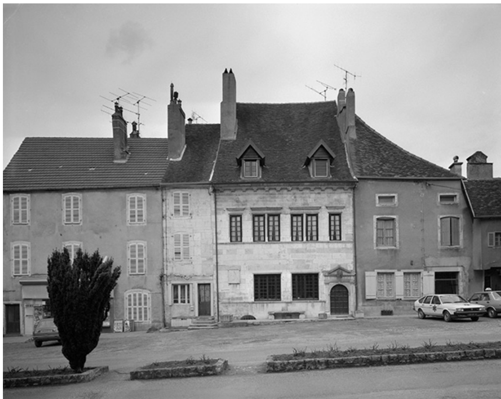
Vue d'ensemble depuis la rue.
