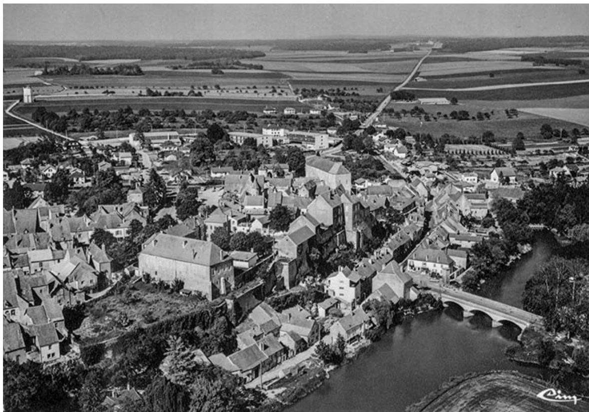
Vue aérienne du bas du village avec le pont sur l'Ognon. 70, Pesmes
