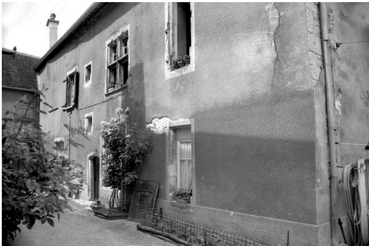
Façade sur impasse.
