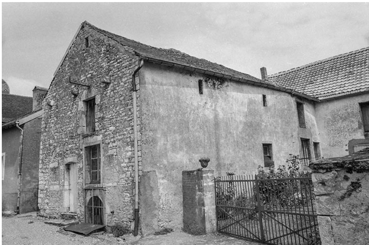
Maison située 7 rue Sainte-Catherine : façades antérieure et latérale droite. 70, Pesmes
