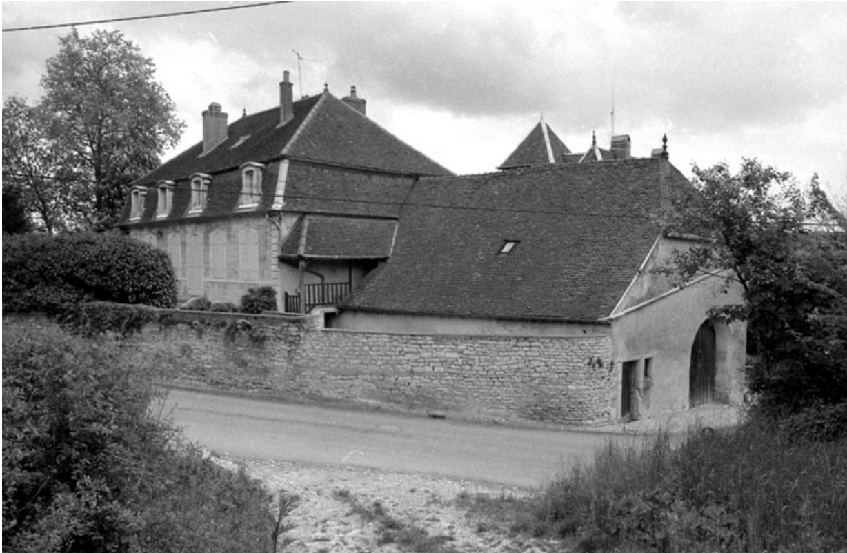
Façade postérieure et latérale droite. 70, Motey-Besuche route de Chancey
