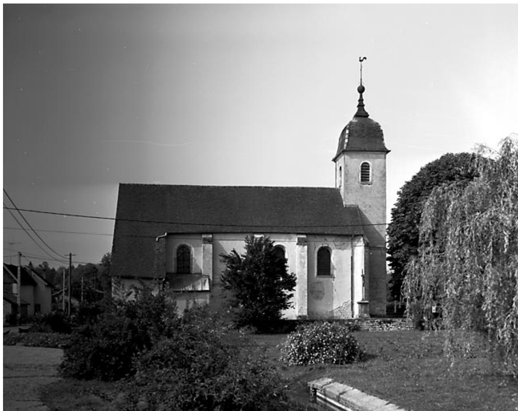
Façade latérale gauche. 70, Motey-Besuche
