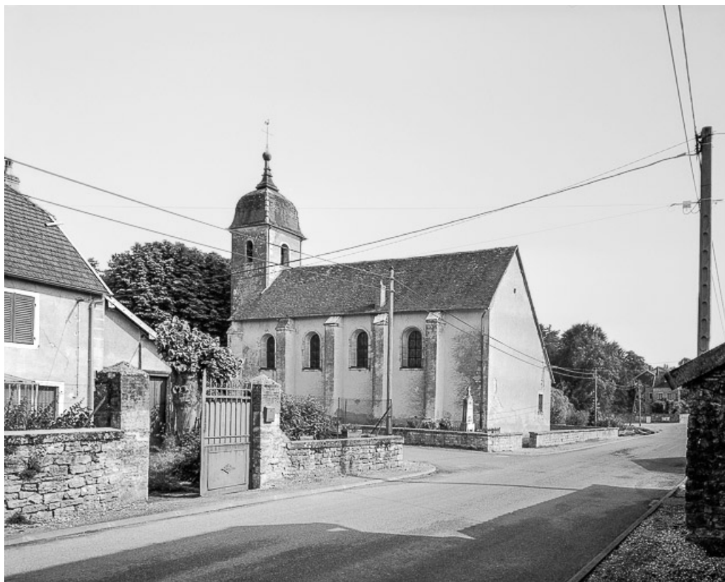
Façade latérale droite et chevet.
