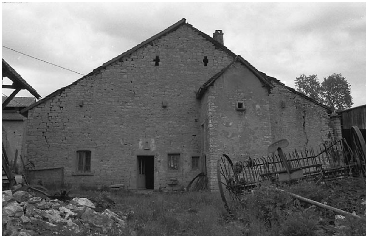
Façade antérieure sur cour.
