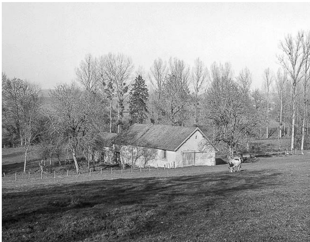
Vue d'ensemble éloignée du revers des bâtiments.
