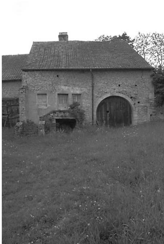
Façade antérieure sur cour.
