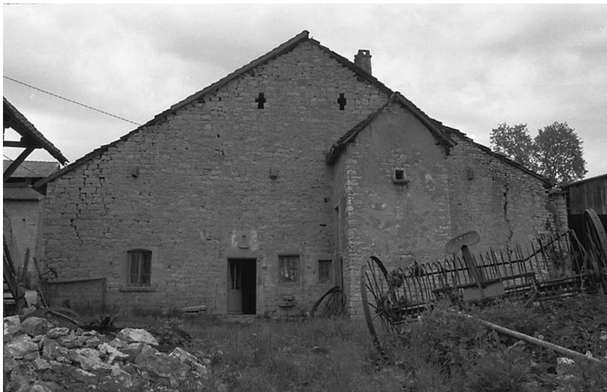
Façade antérieure sur cour.
