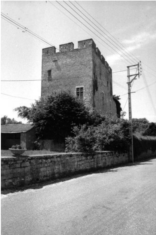
Façade latérale depuis la rue.
