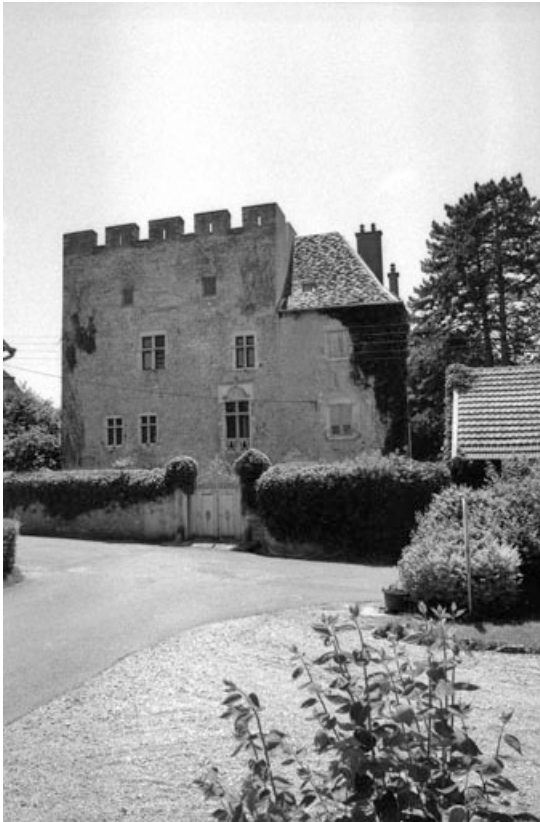
Façade antérieure depuis la rue.
