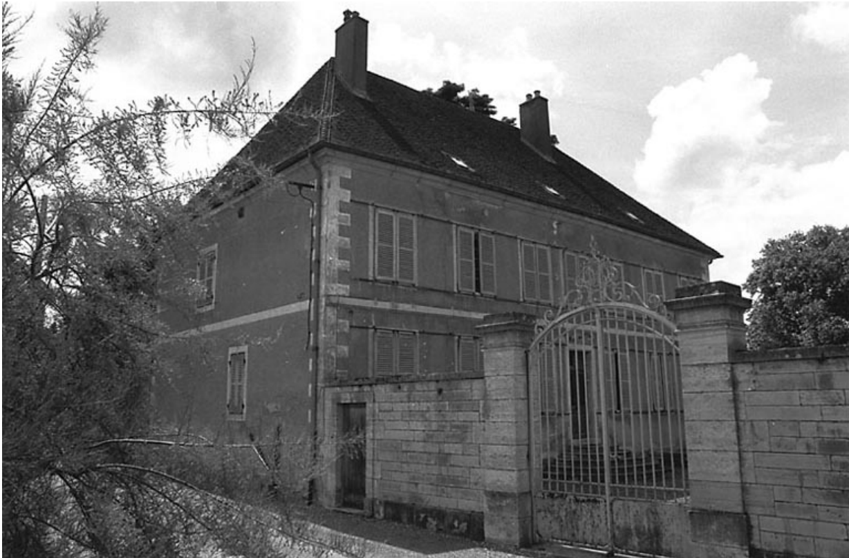
Vue de l'habitation depuis la rue. 70, Montagney rue Neuve
