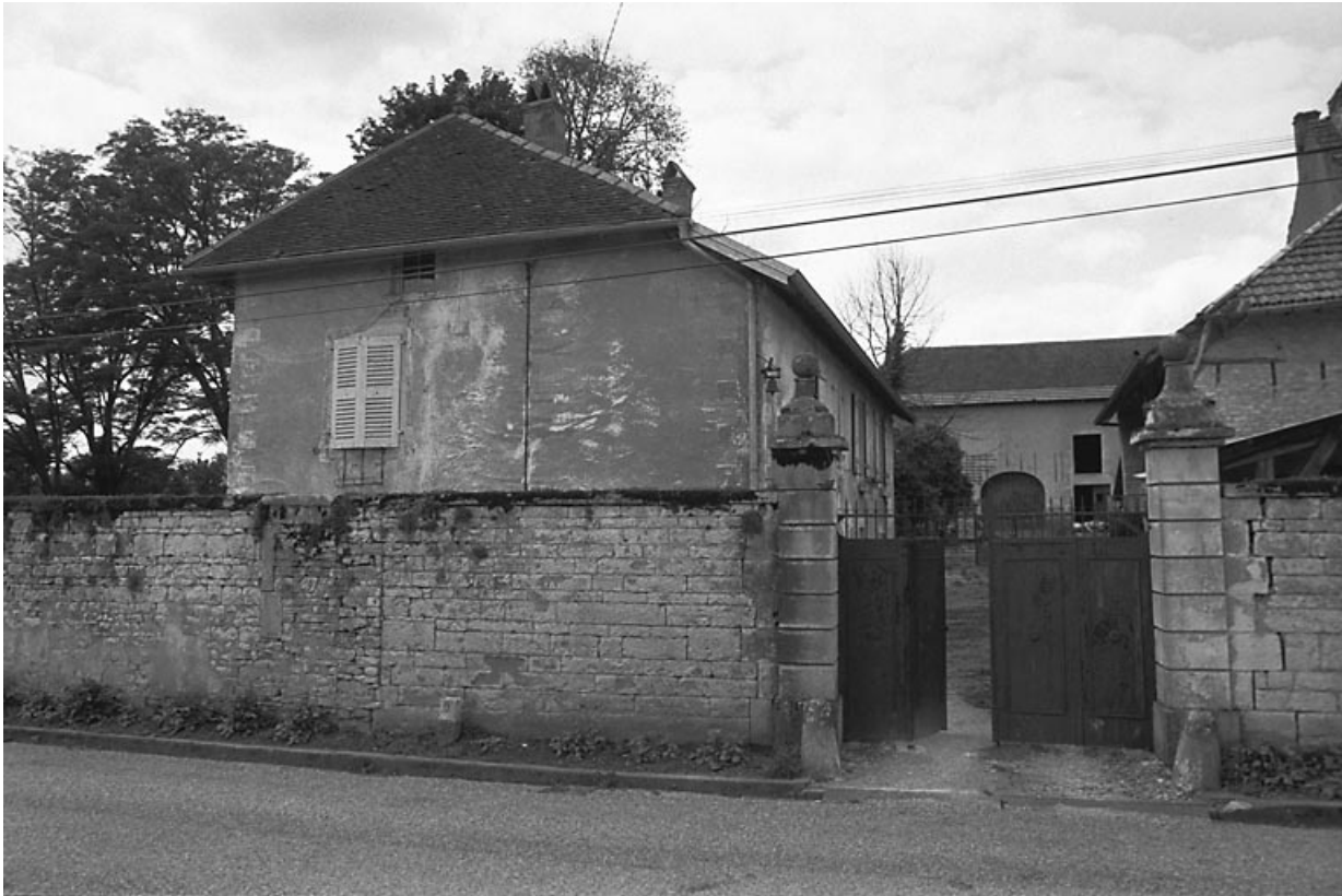
Vue d'ensemble depuis la rue. 70, Montagney
