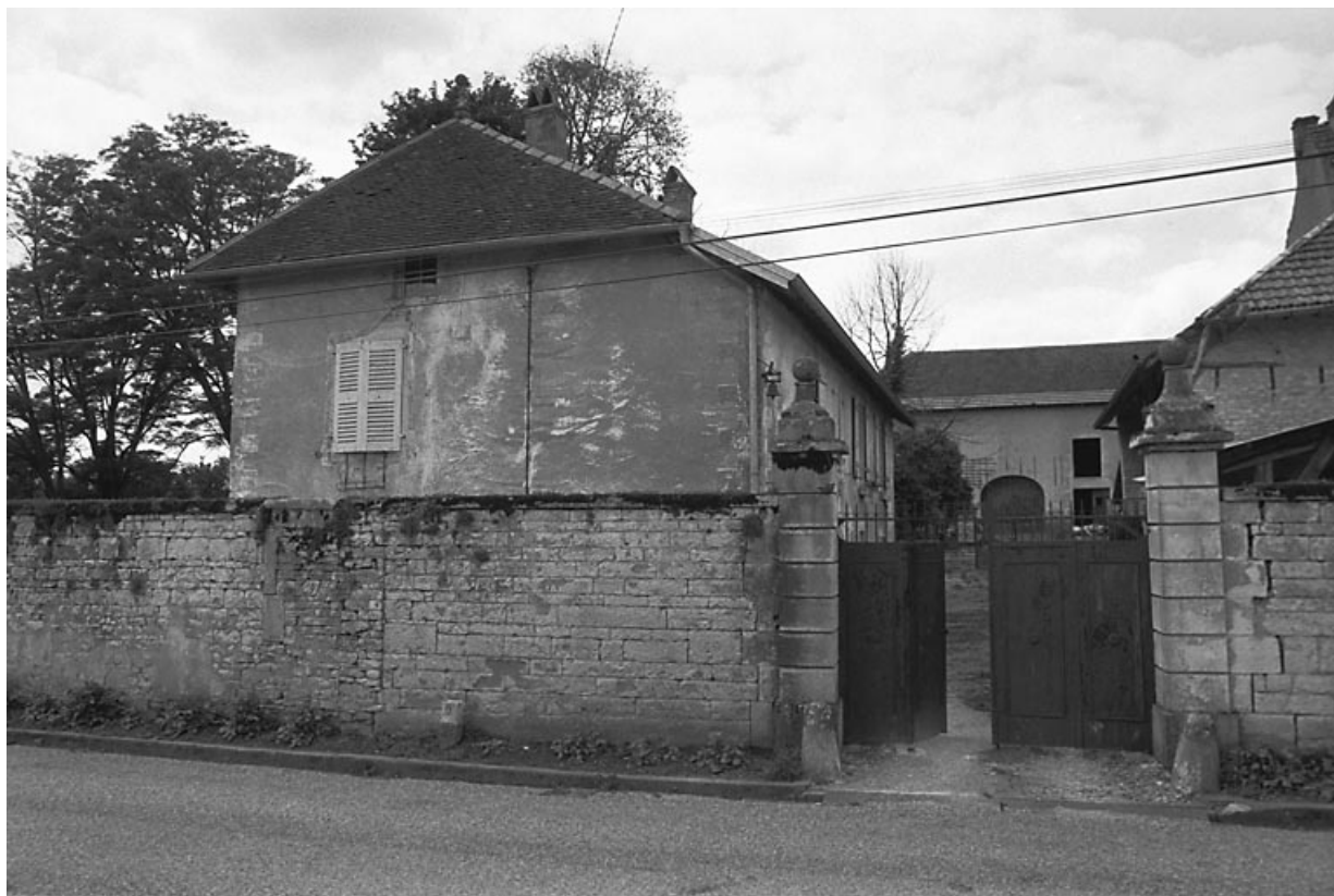
Vue d'ensemble depuis la rue.
