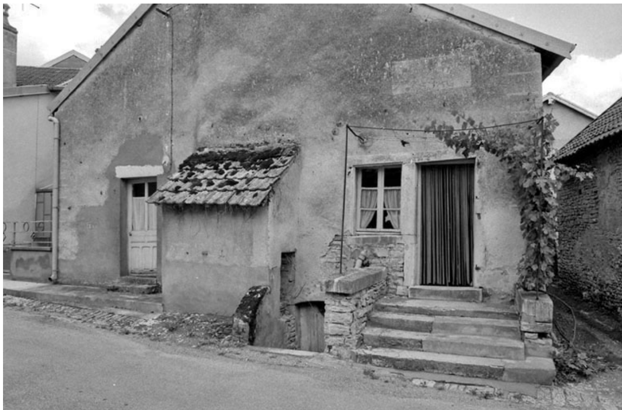
Maison cadastrée 1954 B1 163, située rue de Bresilley : façade antérieure. 70, Montagney
