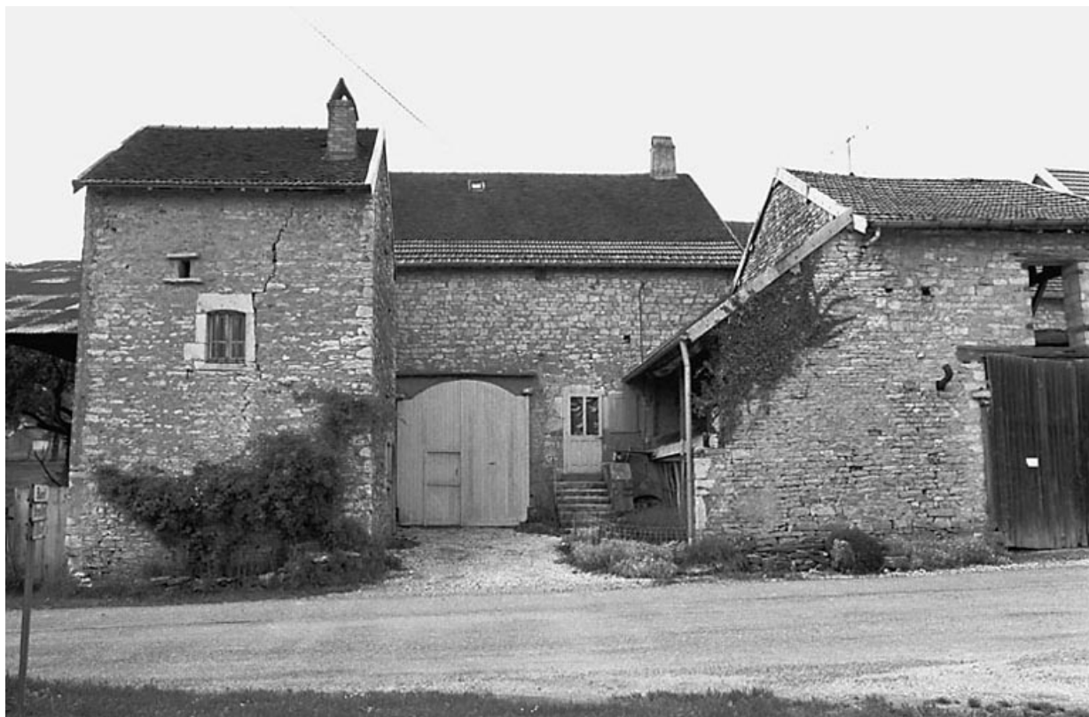
Vue d'ensemble depuis la rue.
