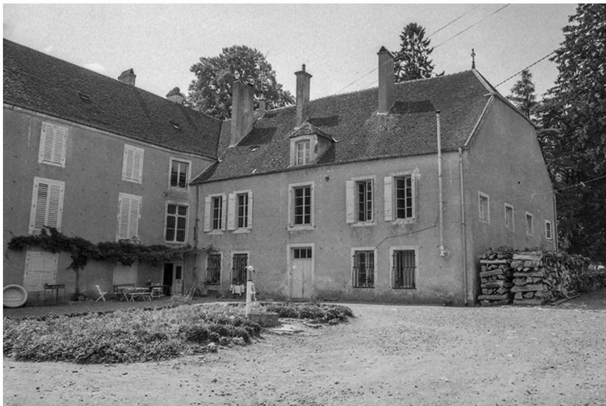
Vue de l'habitation depuis la cour.
