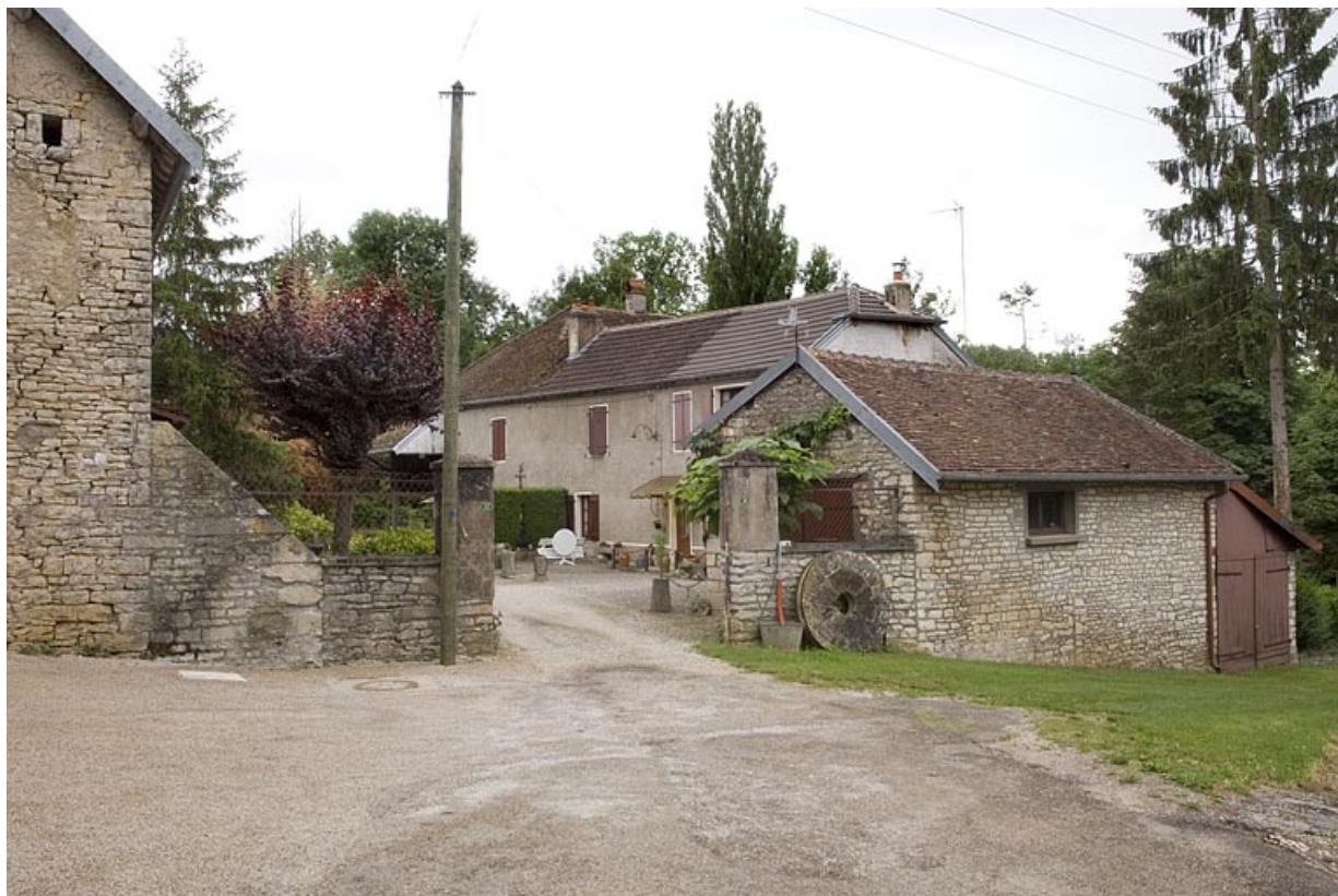
Vue d'ensemble depuis la rue.
