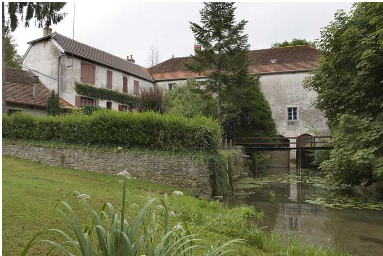
Vue d'ensemble depuis le bief, en aval.
