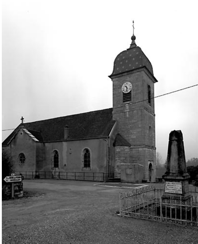
Façades antérieure et latérale gauche. 70, Malans
