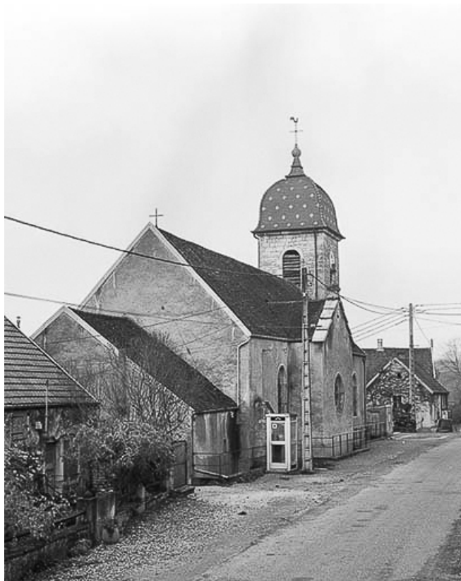
Façade postérieure . 70, Malans
