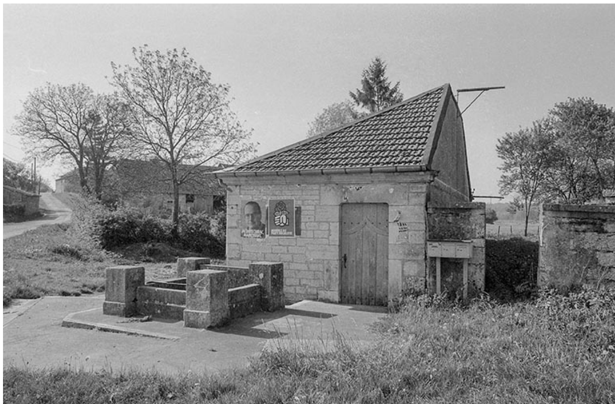
Façade latérale droite.
