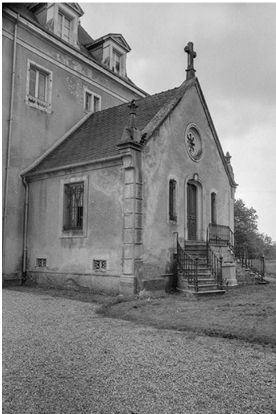
la chapelle sur façade latérale droite. 70, La Grande-Résie route de Choye
