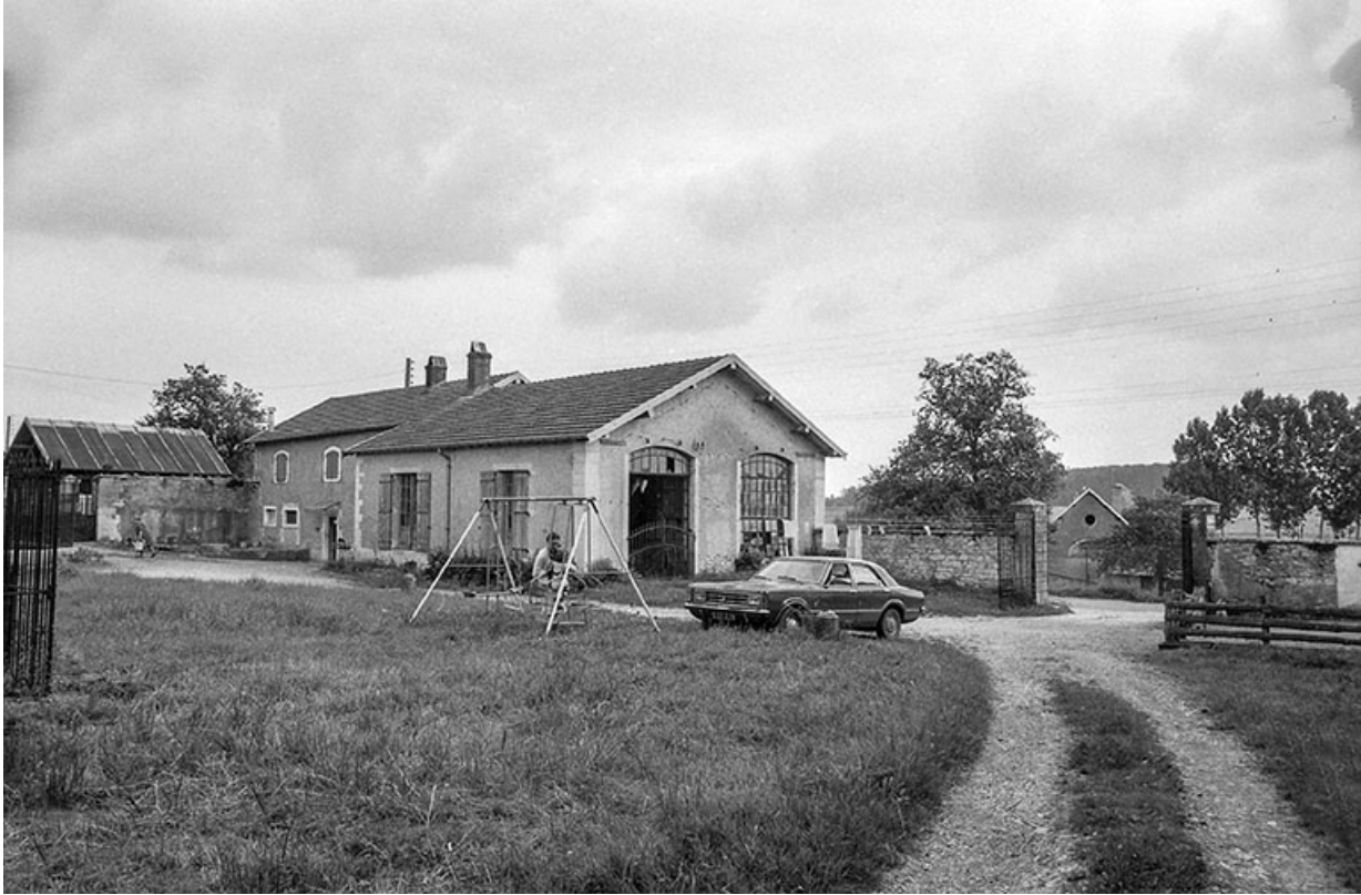
Les communs, partie droite. 70, La Grande-Résie route de Choye
