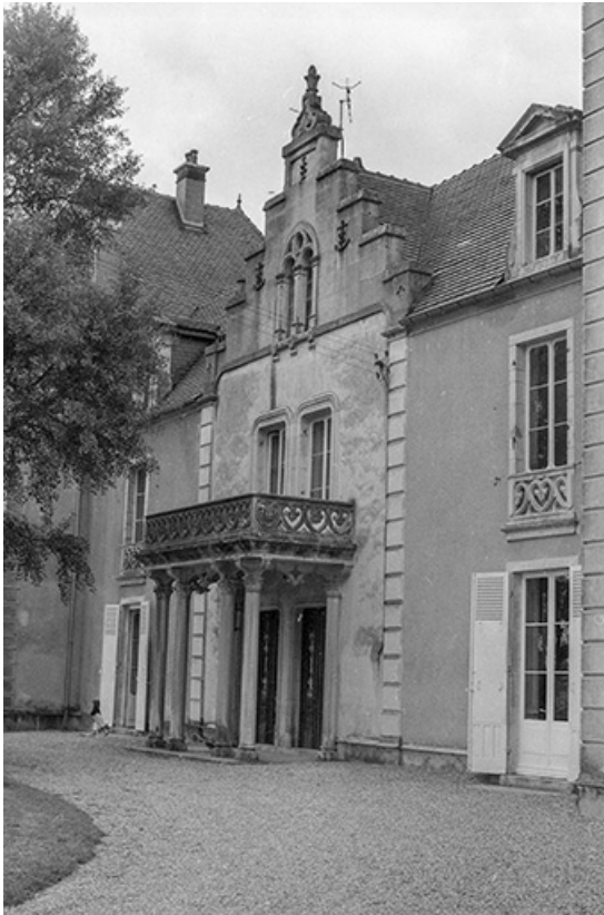
Façade antérieure : portique d'entrée.
