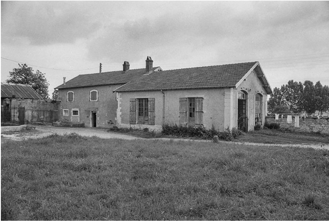
Les communs : bâtiments sur rue. 70, La Grande-Résie route de Choye
