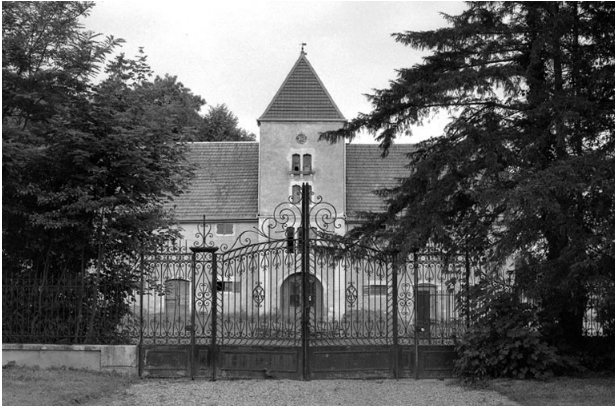
Les communs, vue depuis la cour.
