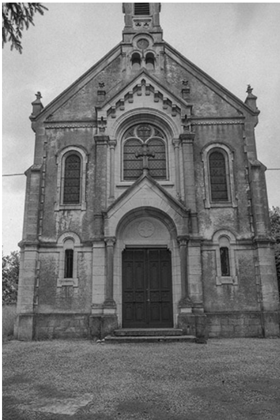
Façade antérieure : vue rapprochée.
