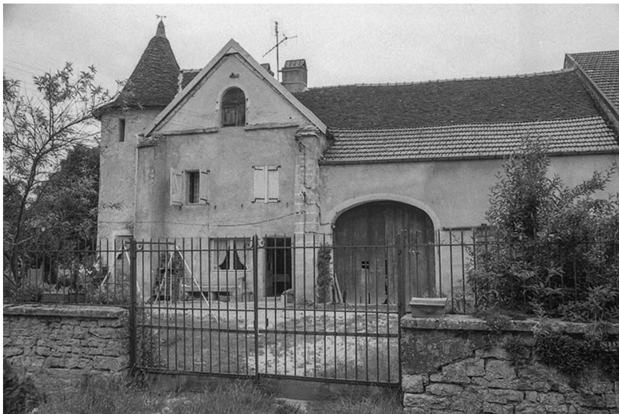
Façade antérieure depuis la cour.
