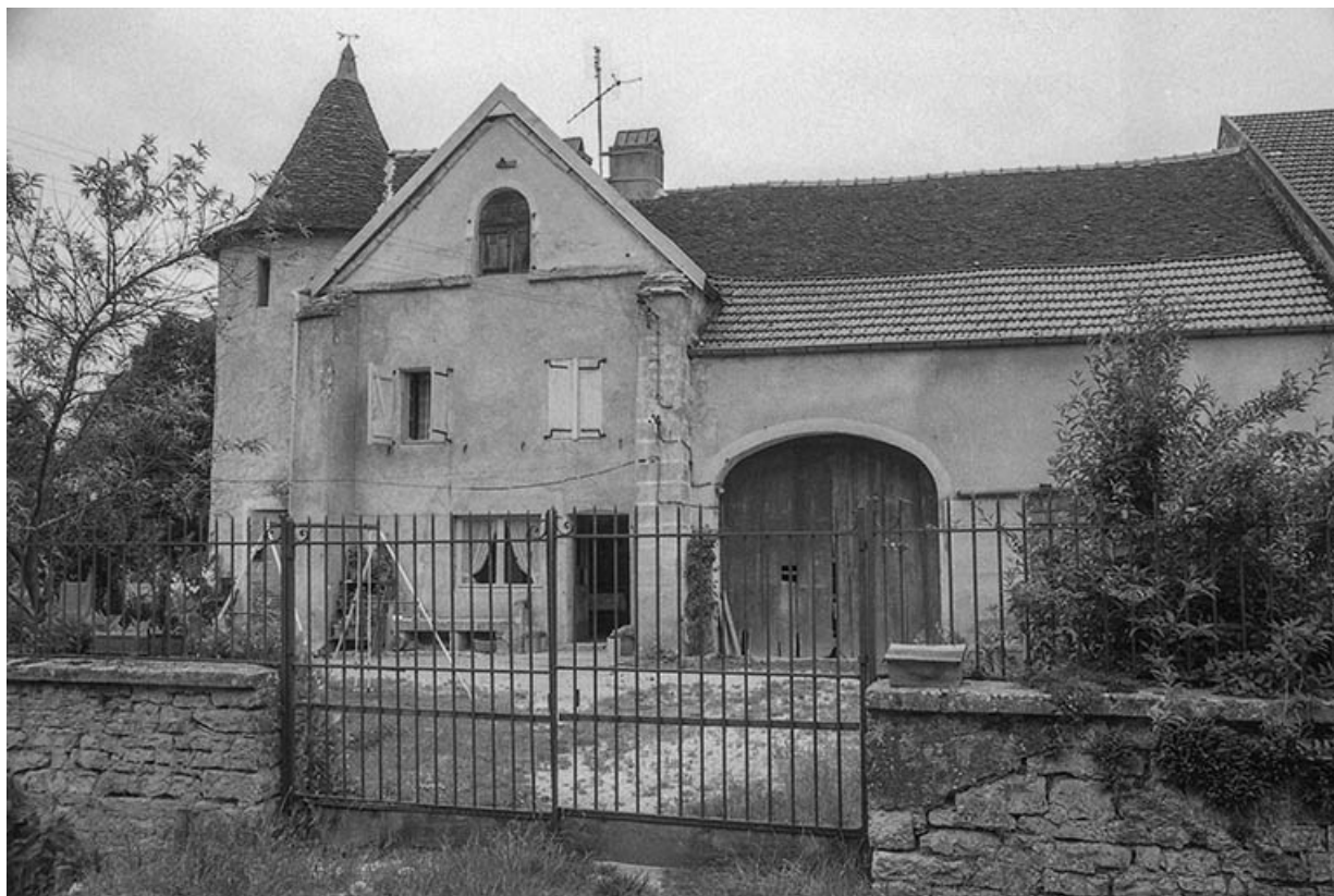
Façade antérieure depuis la cour.
