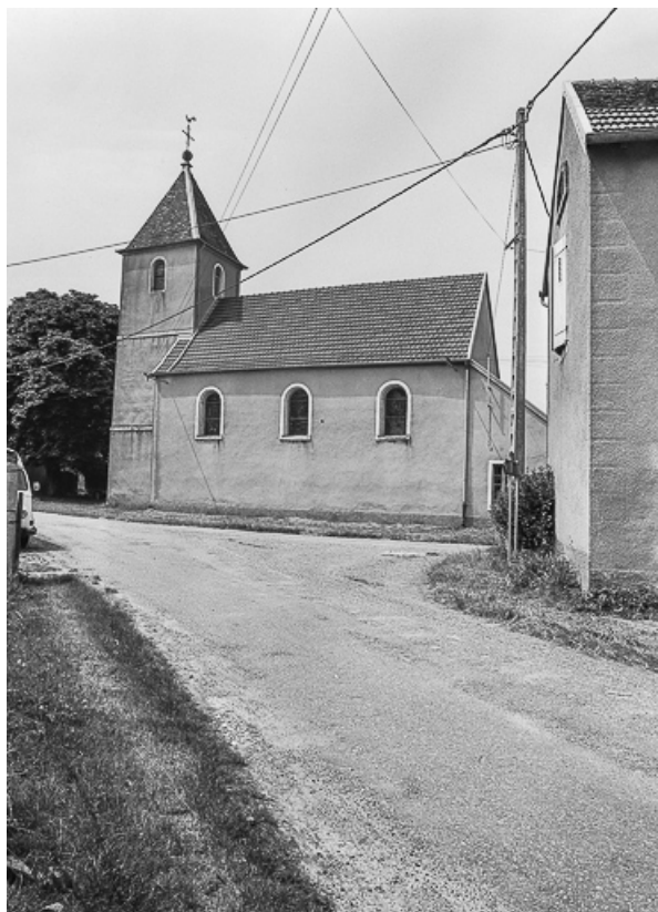
Façade latérale droite.
