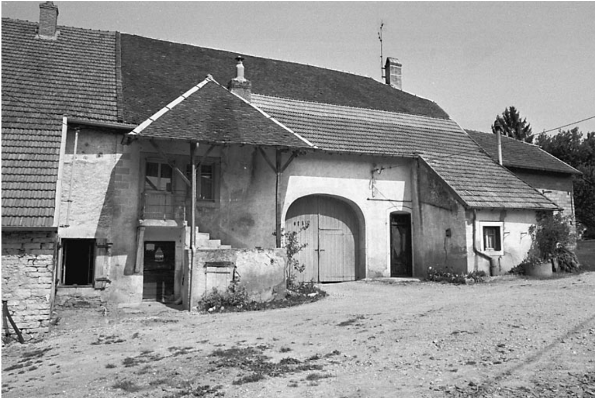
Façade antérieure : vue rapprochée. 70, Chevigny
