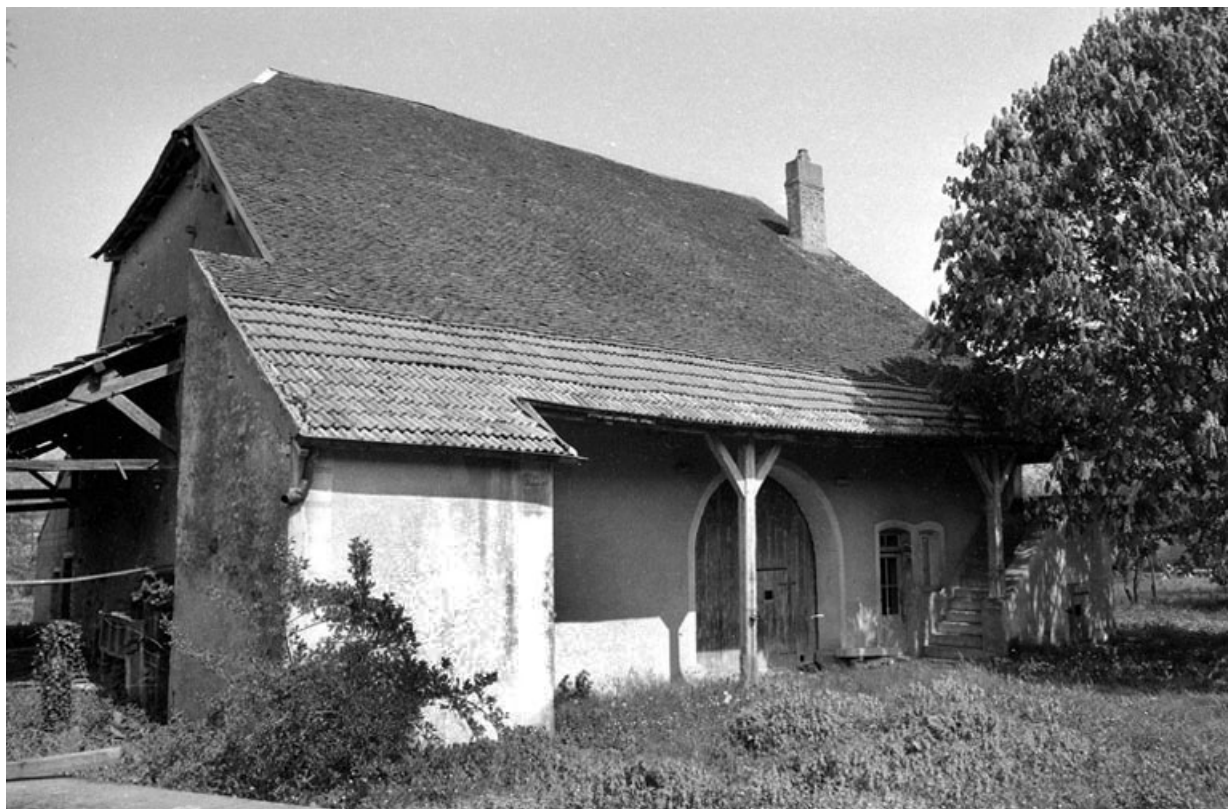
Façade antérieure vue de trois quarts gauche.
