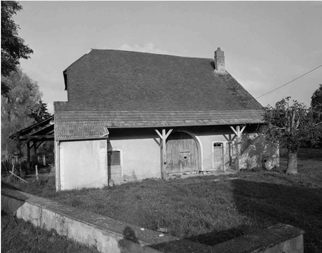
Vue d'ensemble depuis la rue.
