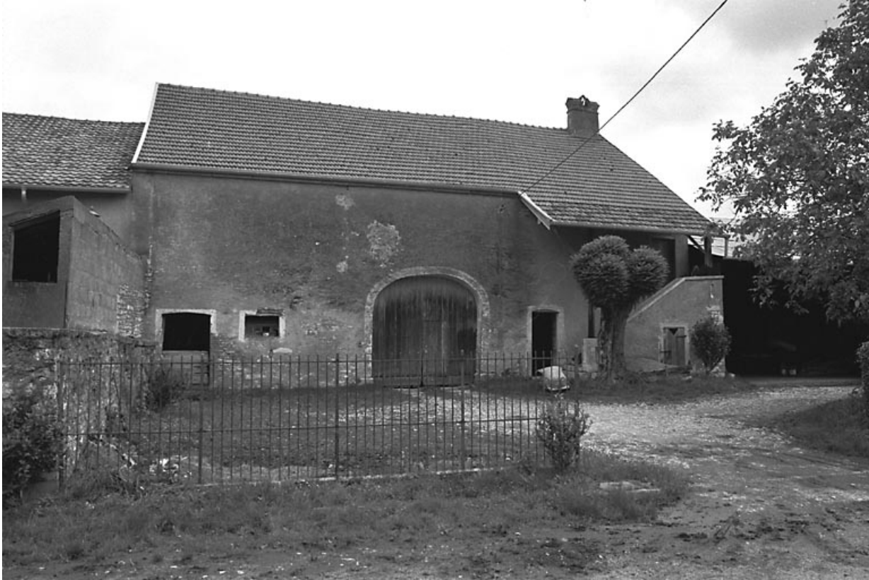
Façade antérieure sur cour.
