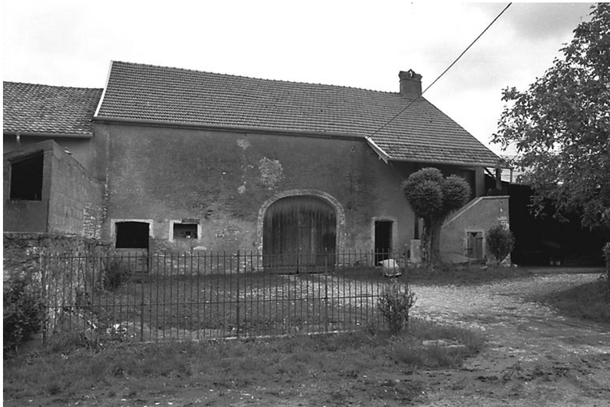
Façade antérieure sur cour.
