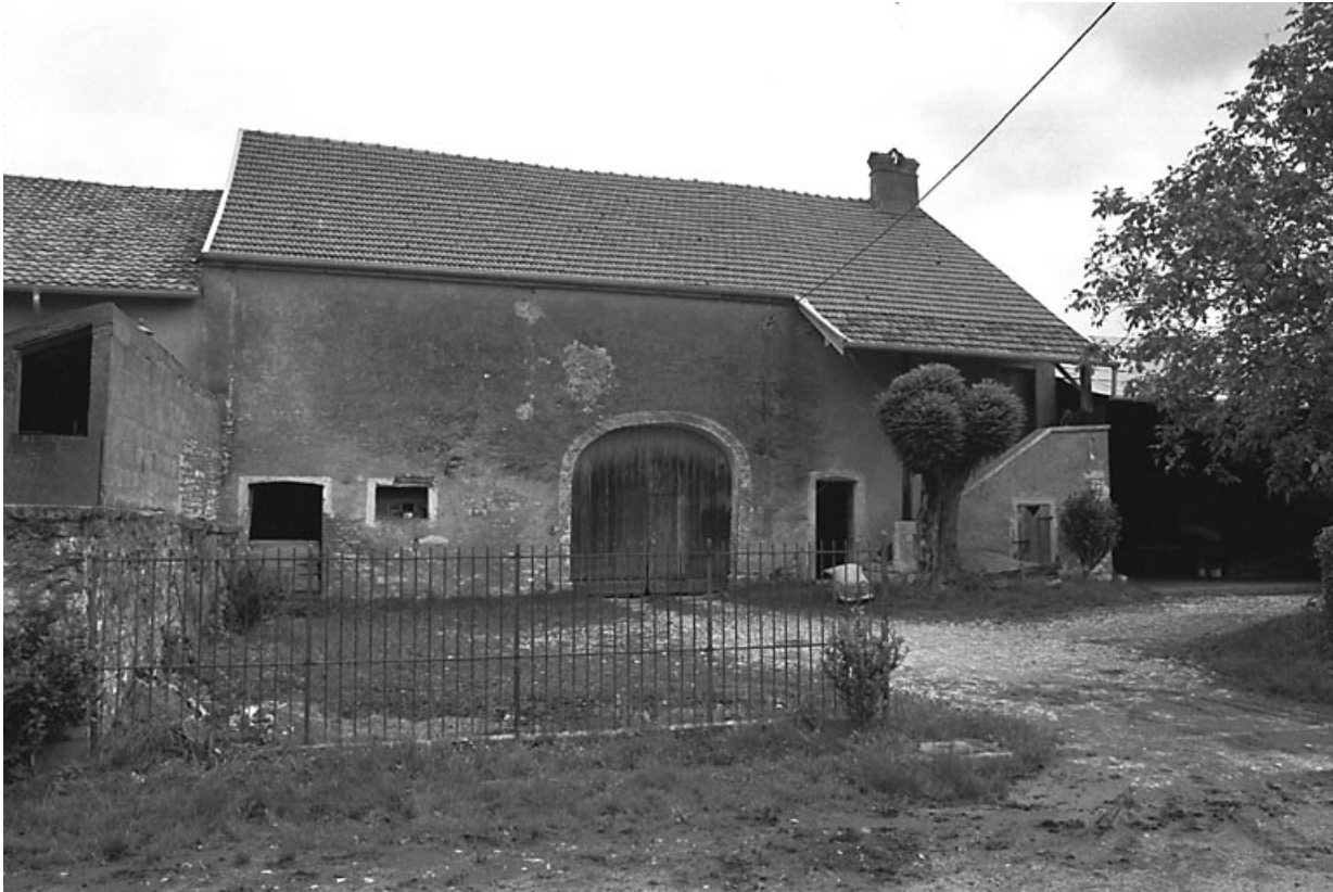
Façade antérieure sur cour.
