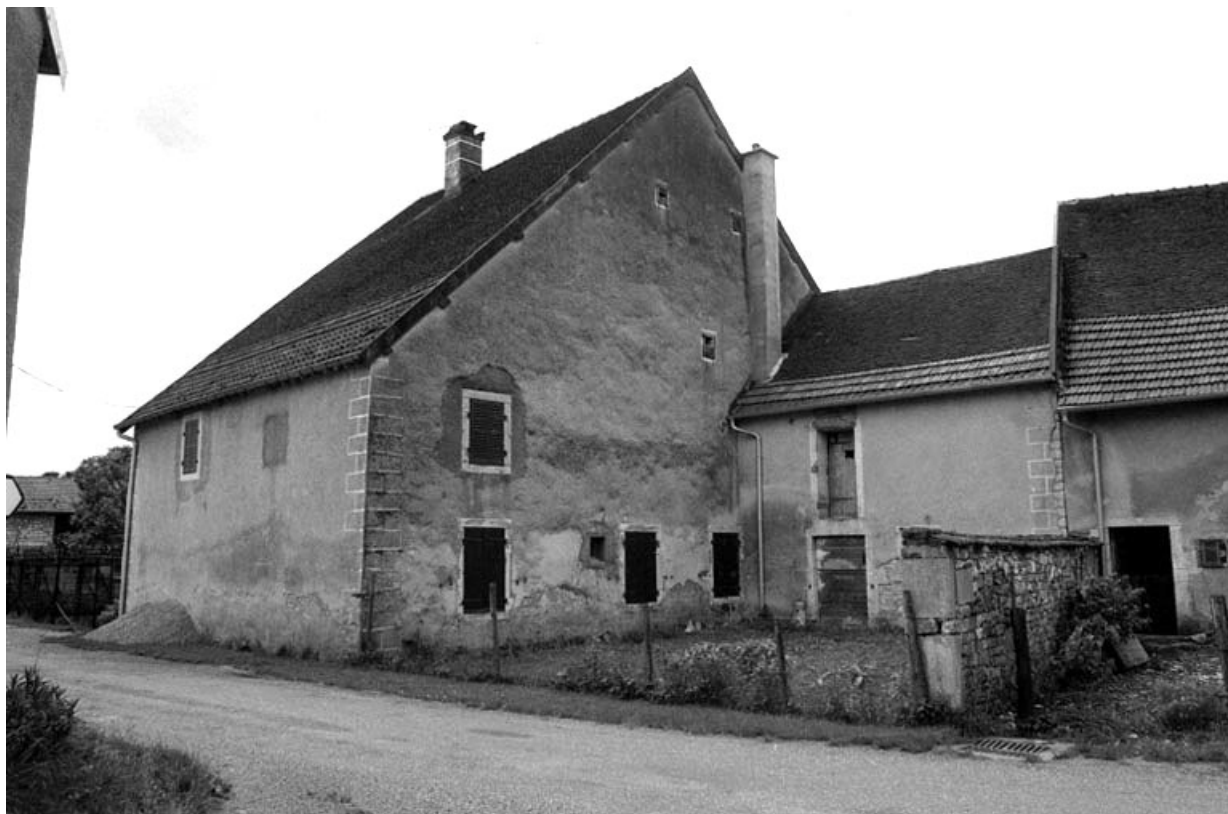
Façades postérieures et latérales droite.
