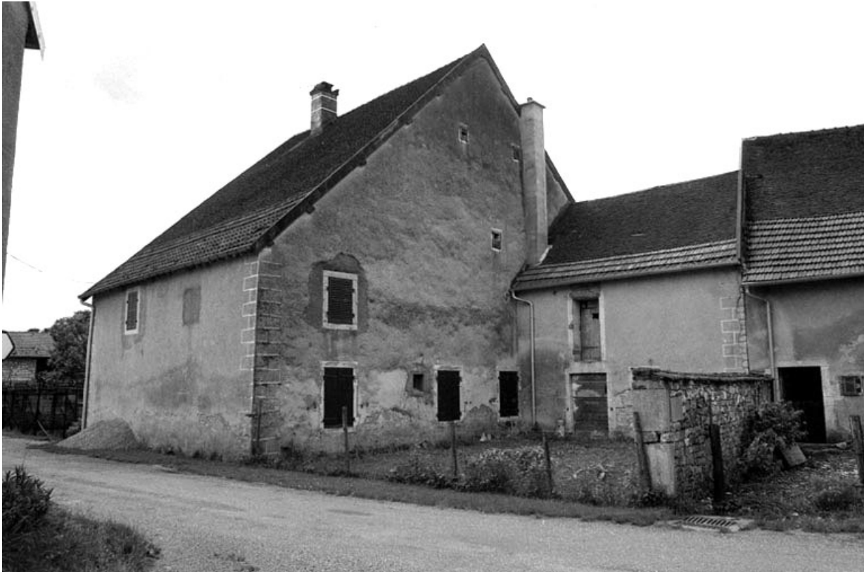
Façades postérieures et latérales droite.
