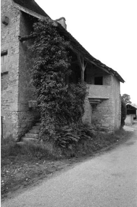
Détail de l'escalier extérieur sur façade antérieure.
