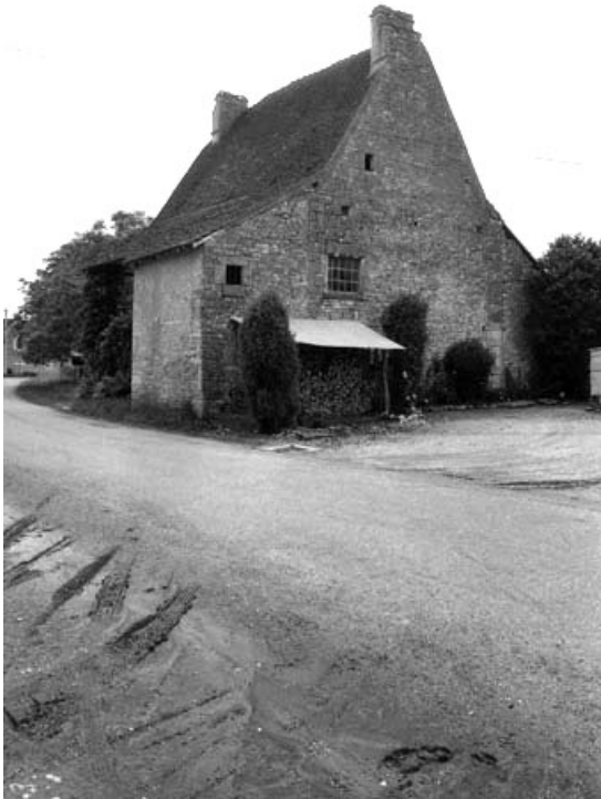
Façade latérale droite.
