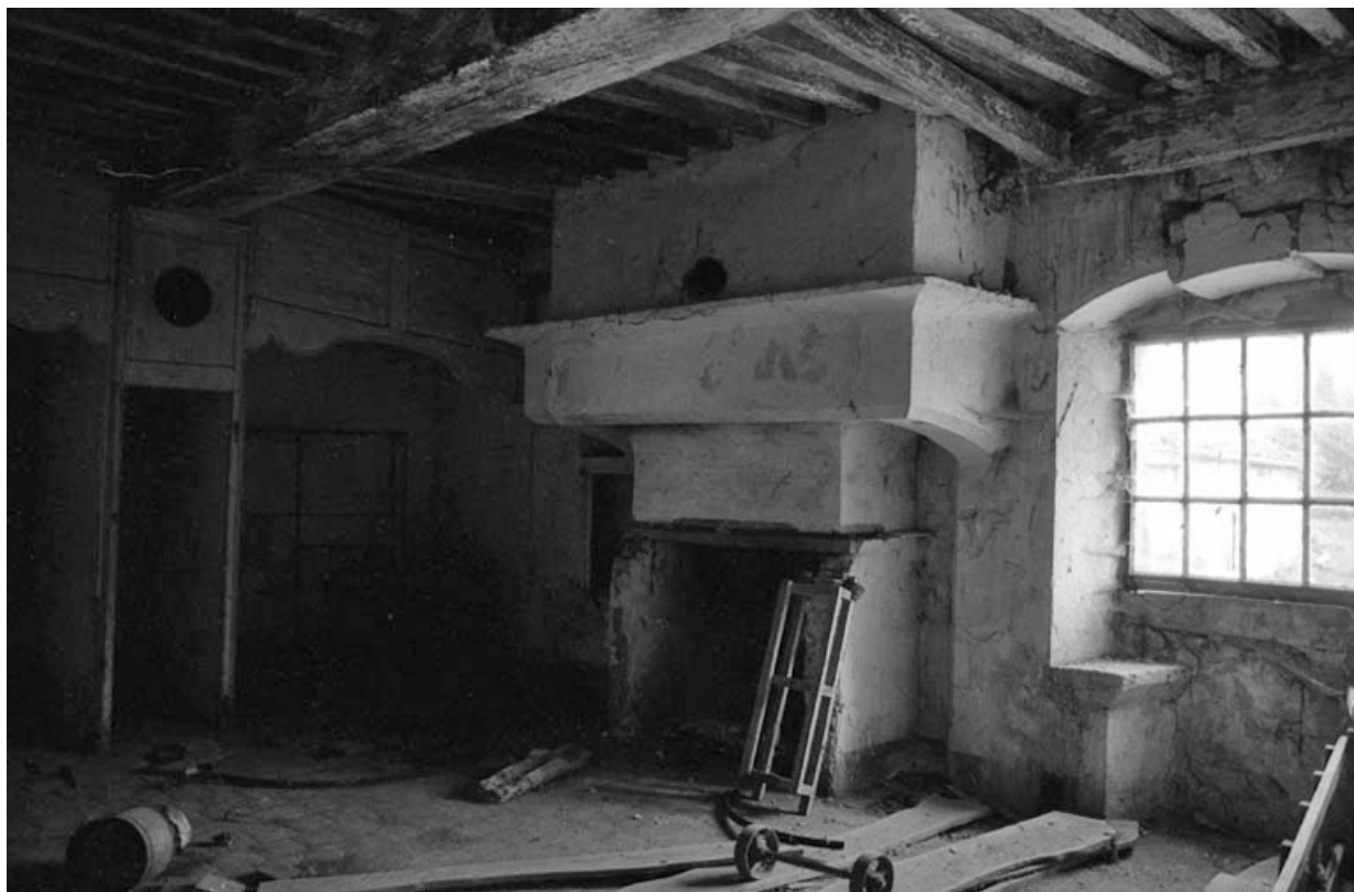
Intérieur : vue de la cheminée.
