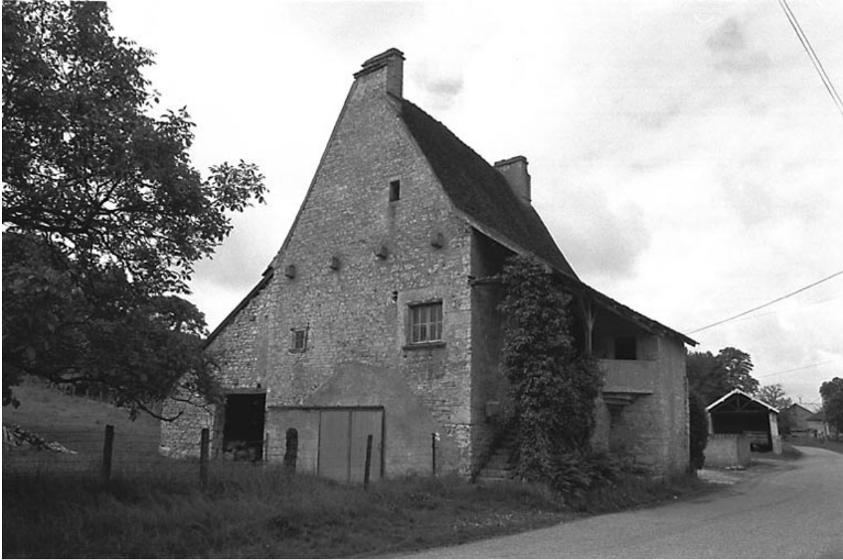
Façades antérieure et latérale gauche.
