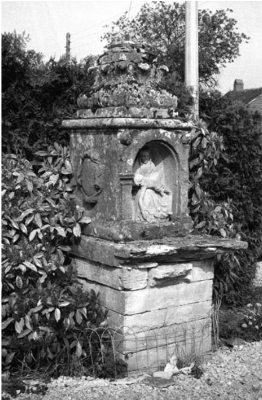
Vue d'ensemble du socle.
