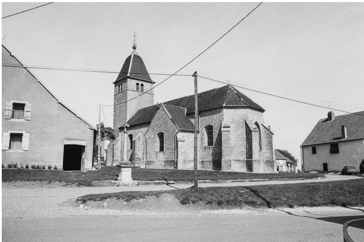
Façade latérale droite.
