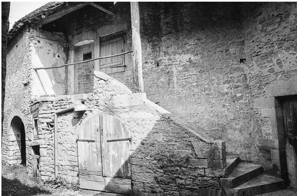
L'habitation, à gauche dans la cour.
