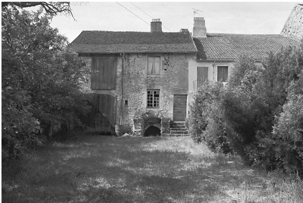
Façade antérieure sur cour.
