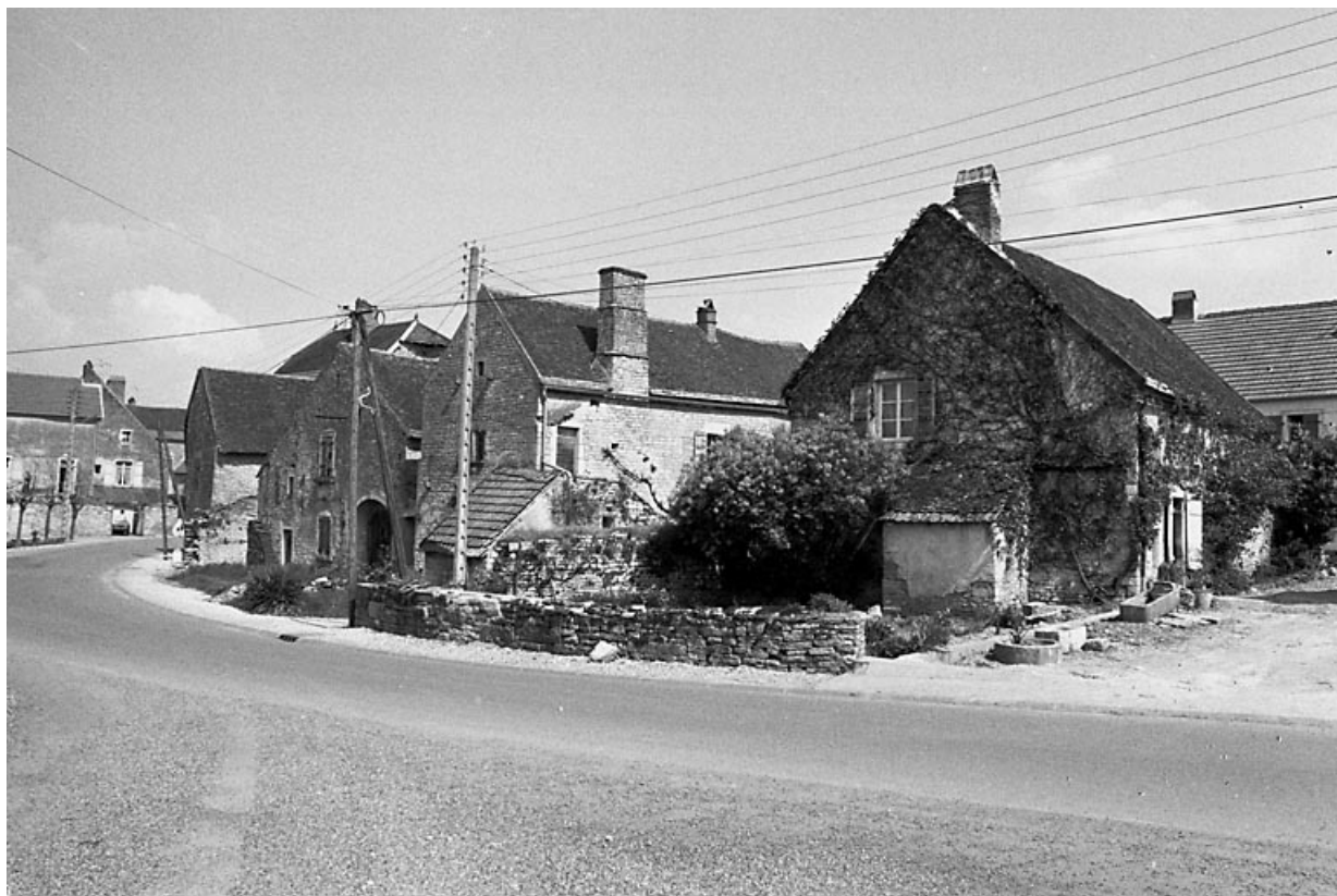
Rue du village avec maisons présentant toutes un pignon sur rue. 70, Chaumerenne
