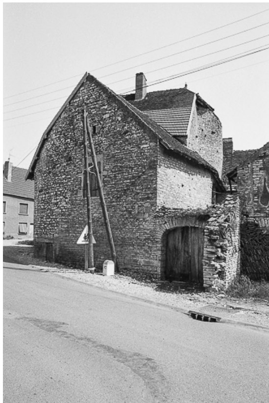
Vue de l'entrée de la cour depuis la rue.
