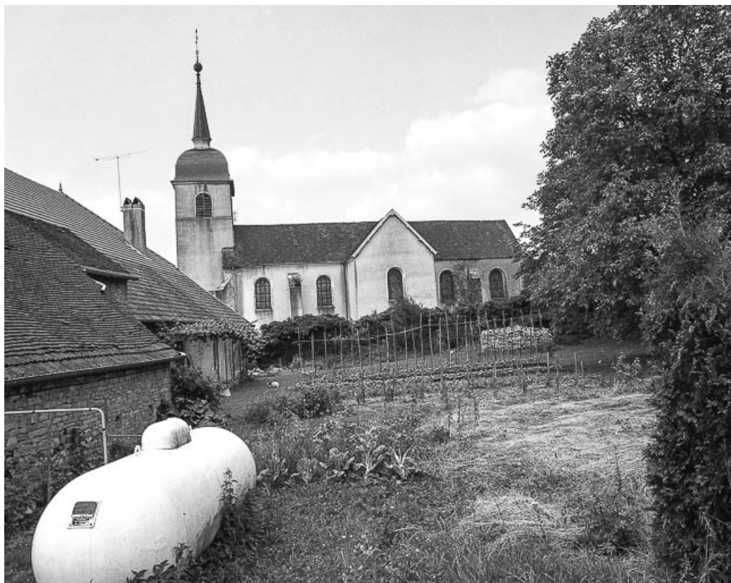
Façade latérale droite.
