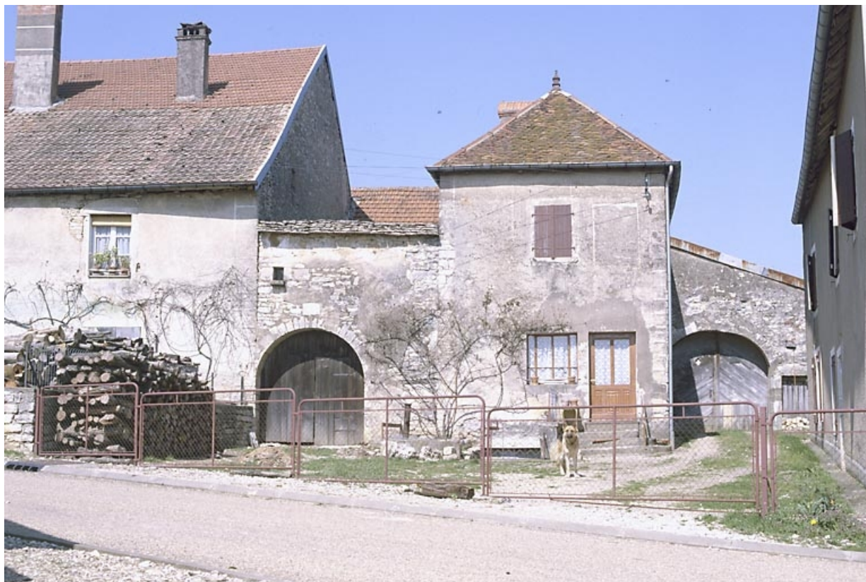
Façade antérieure sur cour en 1985.
