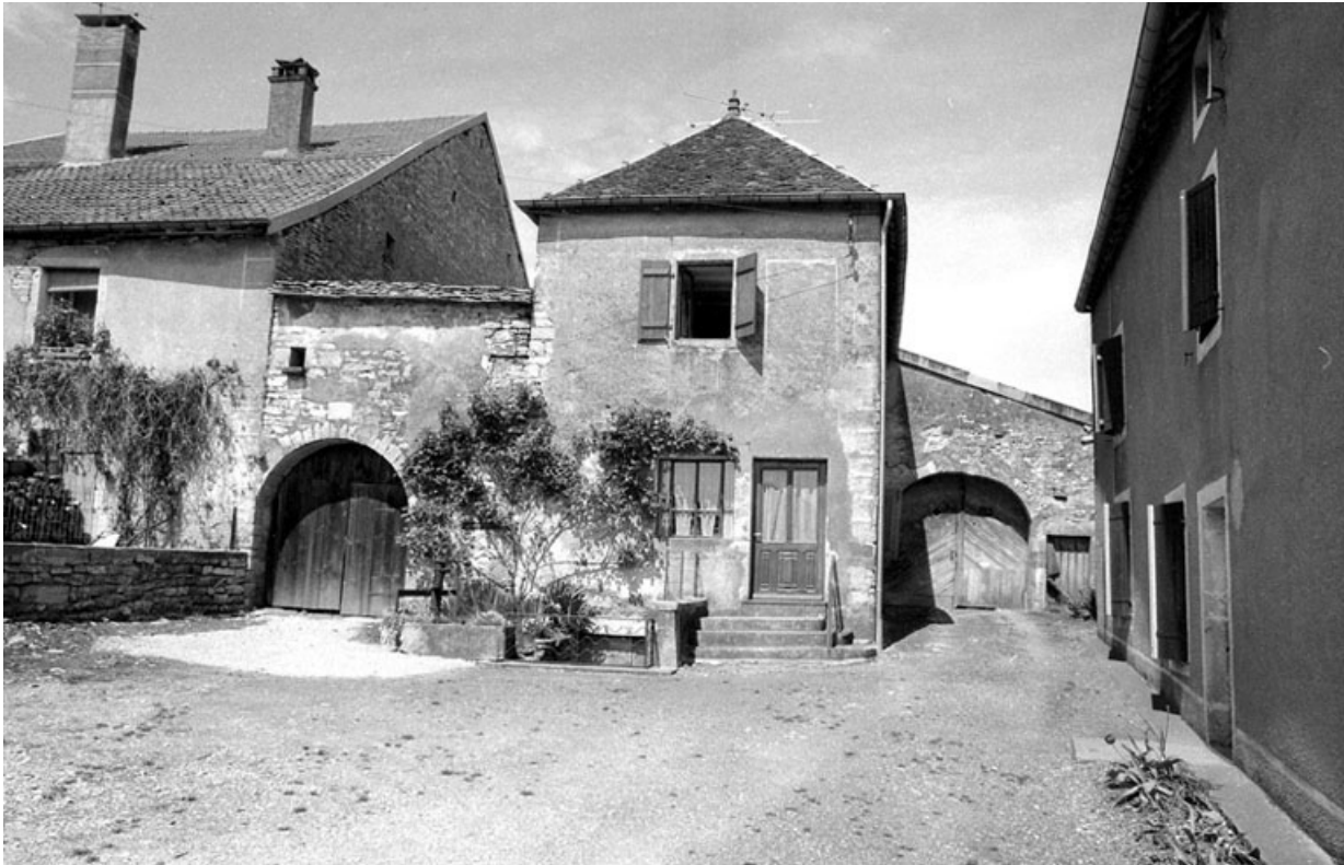
Façade antérieure sur cour en 1981. 70, Chancey rue Tortueuse
