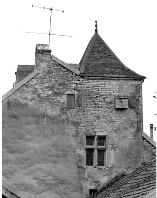
Détail de l'habitation : le pigeonnier au-dessus de la tourelle d'escalier en vis. 70, Chancey rue des Clos
