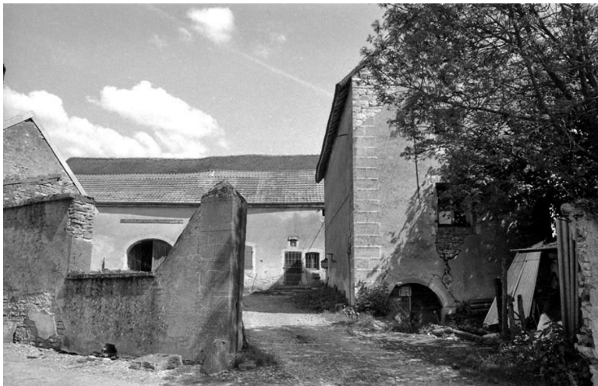
Vue d'ensemble depuis l'entrée de la cour.
