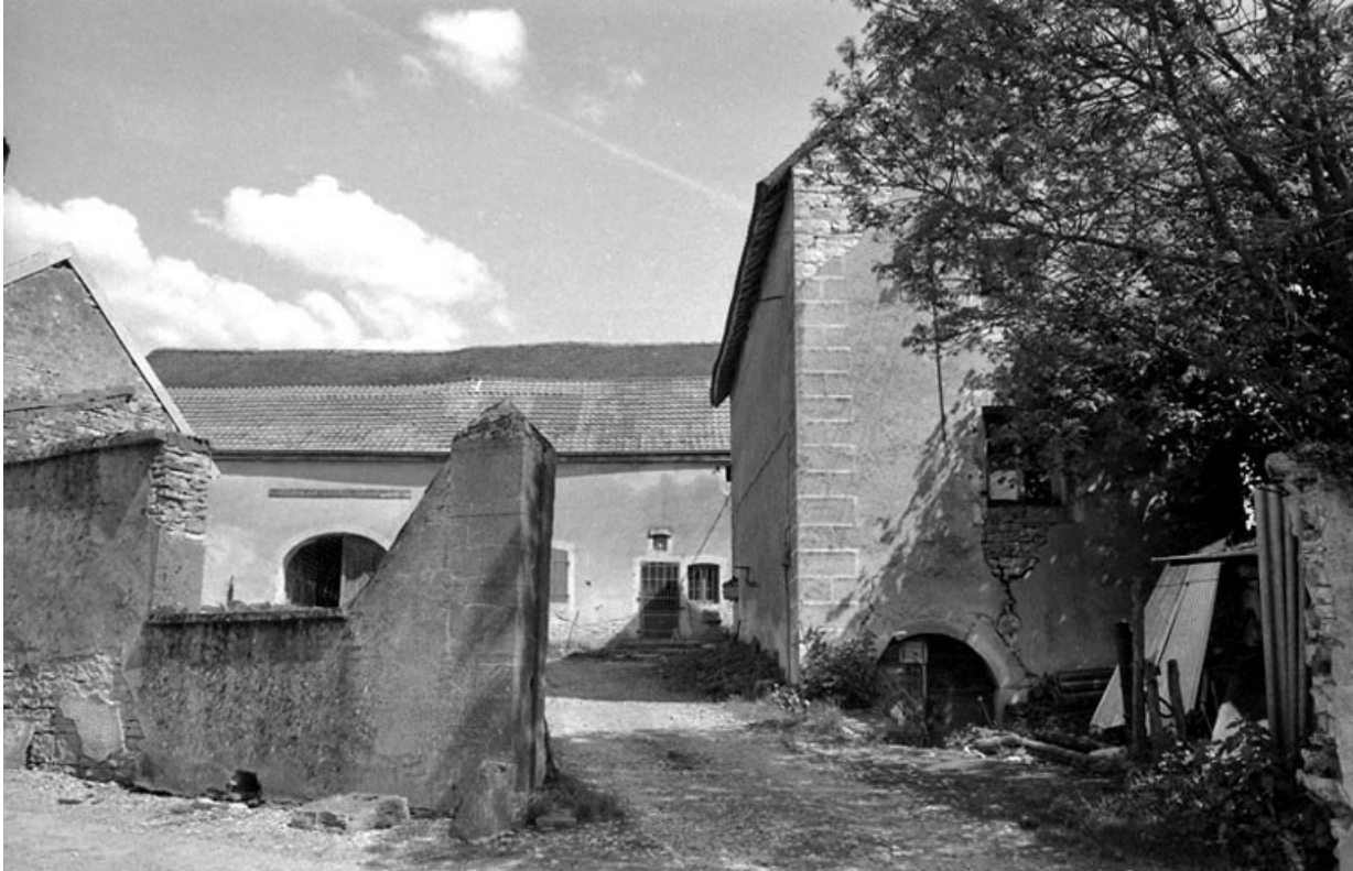
Vue d'ensemble depuis l'entrée de la cour. 70, Chancey impasse des Tilleuls
