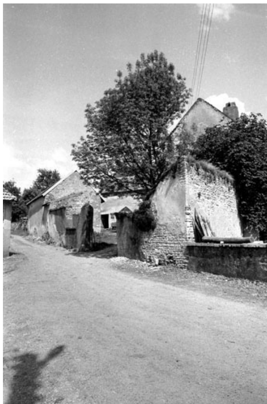
Vue d'ensemble depuis la rue.
