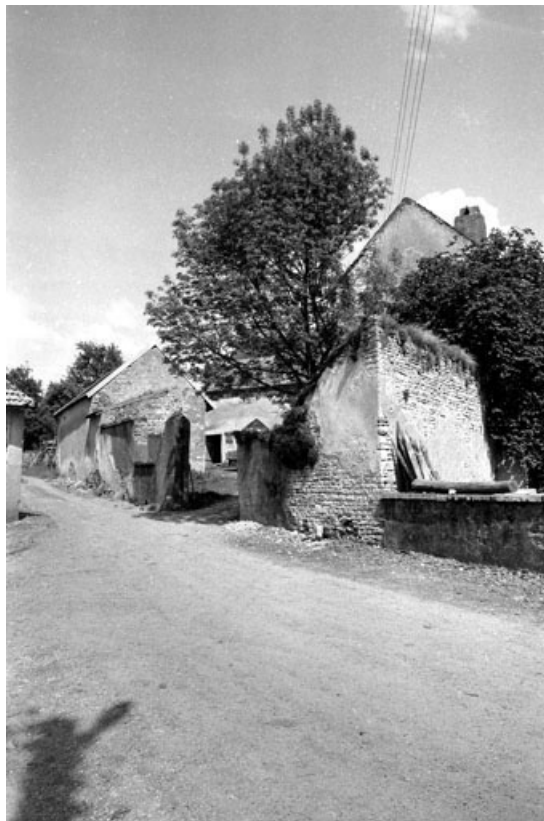
Vue d'ensemble depuis la rue.
