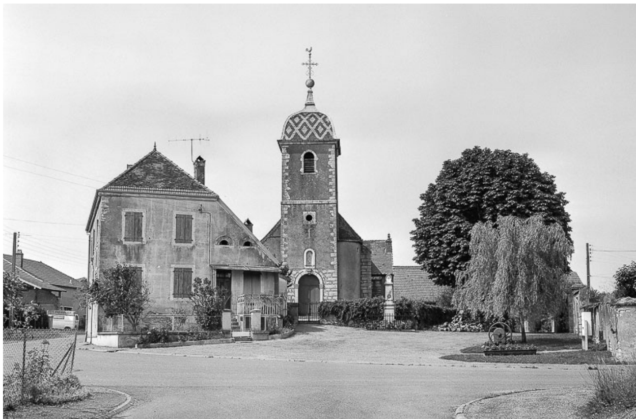
Extérieur : façade antérieure avec tour-clocher.
