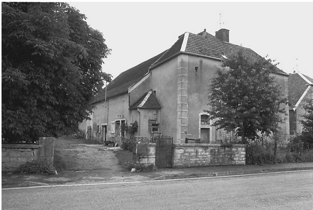
Vue du bâtiment de trois quarts gauche.
