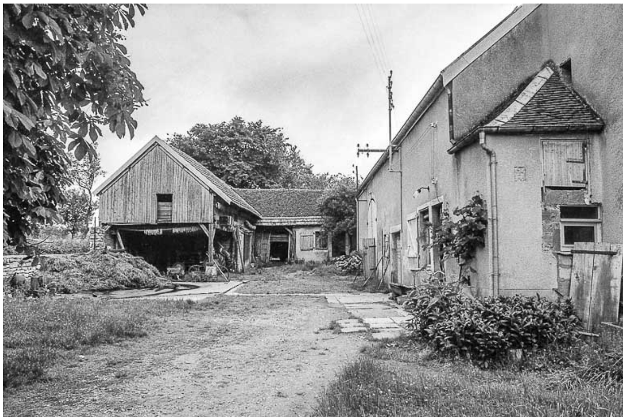
Façade antérieure des parties agricoles et hangar depuis la cour.
