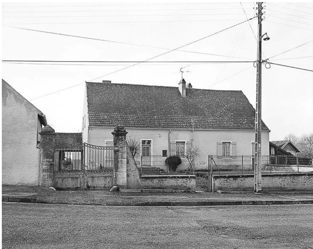
Façade antérieure depuis la cour.
