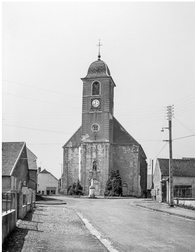
Façade antérieure avec tour-clocher.
