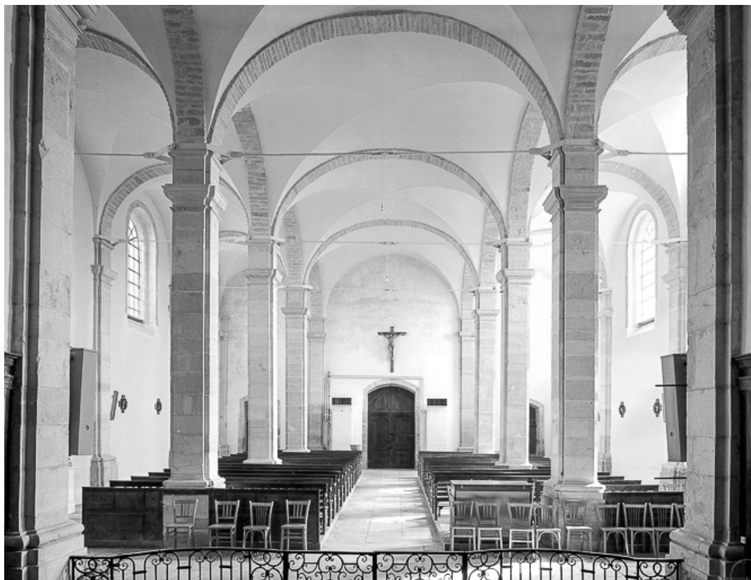
Nef vue depuis le chœur.
