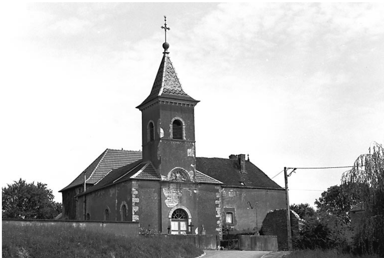
Eglise vue de trois quarts gauche.
