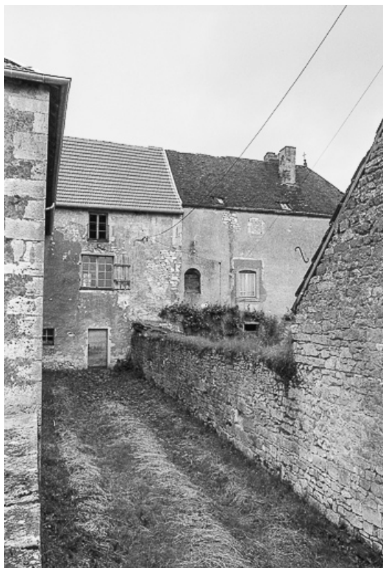
Vue des bâtiments à droite de l'église.
